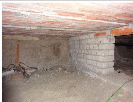
12. Nehobo vloer kruipruimte
