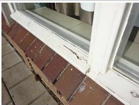
7. Afgebladderd/ verweerd schilderwerk
