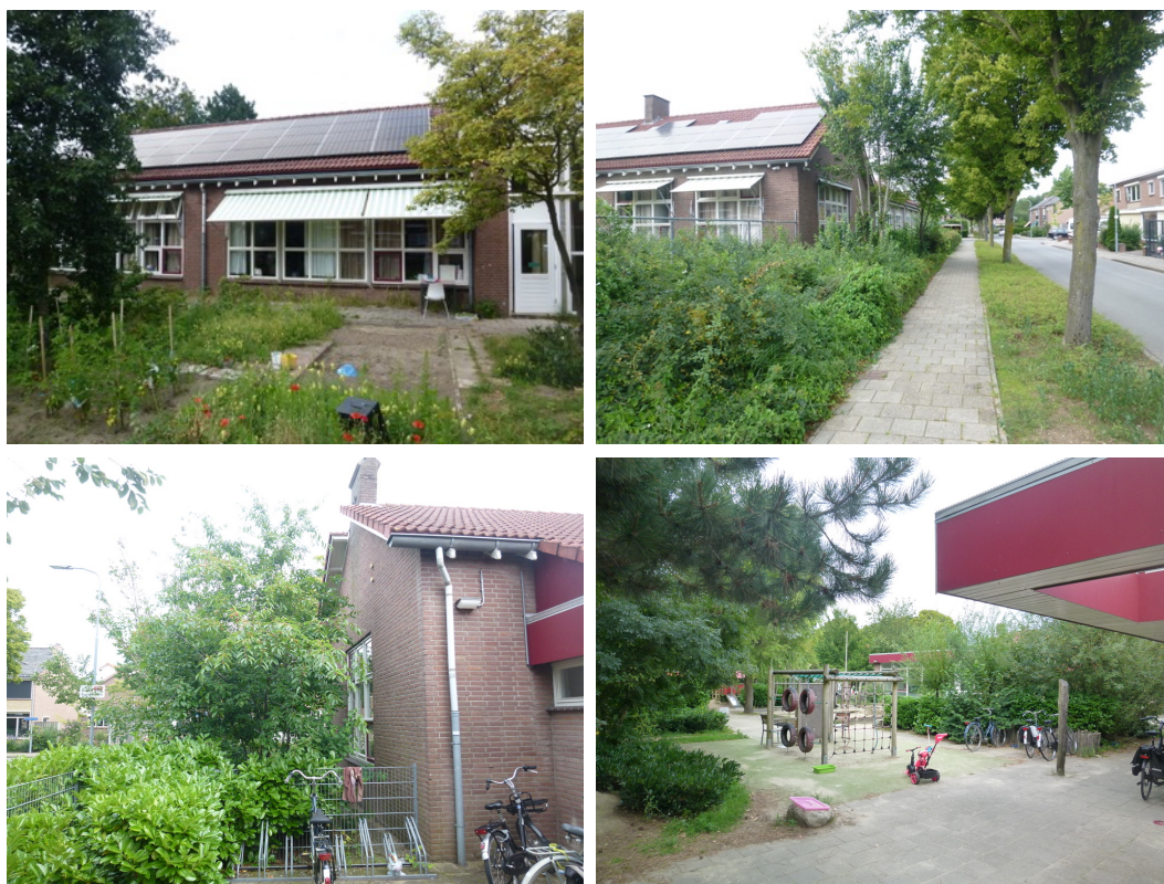
Een indruk van het plangebied; de voorzijde van het plangebied (boven) met links de moestuin op de voorgrond en rechts de bomenrij aan de oostzijde van het plangebied. De beplanting staat op enkele plekken dicht op de bebouwing (linksonder) en het groene schoolplein met speelvoorzieningen (rechtsonder).
