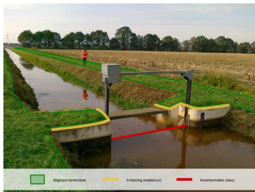
Figuur 3.14 Karteervoorbeelden van een stuw en een schotbalkstuw . Geel is de scheiding en rood het kunstwerkdeel
