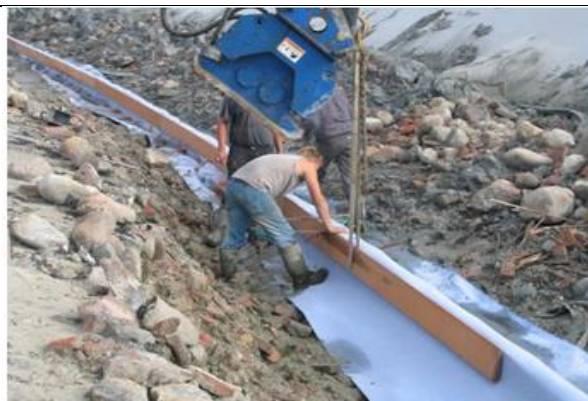
Een teenconstructie in aanbouw (Links) en afgeronde overgangsconstructie (rechts)
