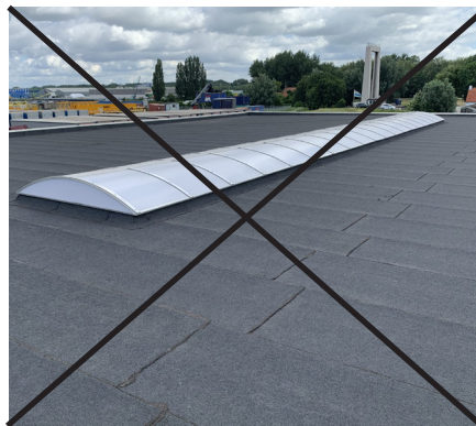
geen bitumineus kaal platdak
