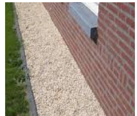
regenwateropvang langs gevels
