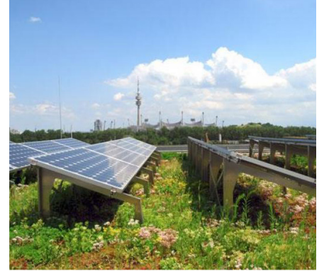
benut het dak voor pv en klimaatadaptatie
