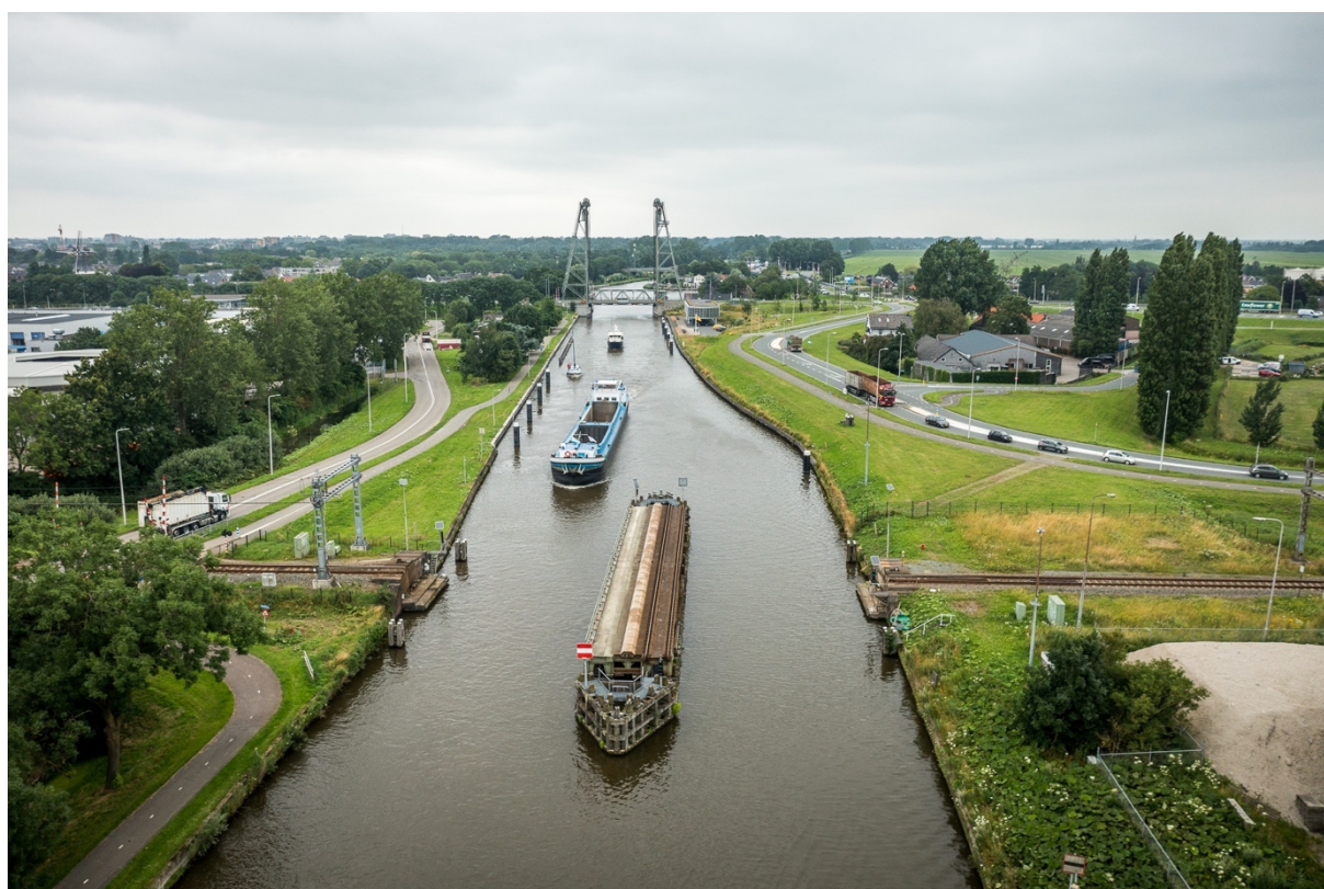
Figuur 2 Vleie spoorbrug (geopend), Pioenbrug en Bedieningscentrum Aalburg aan de Verlaat Bron: NNVO Foto: Rogier Bos
