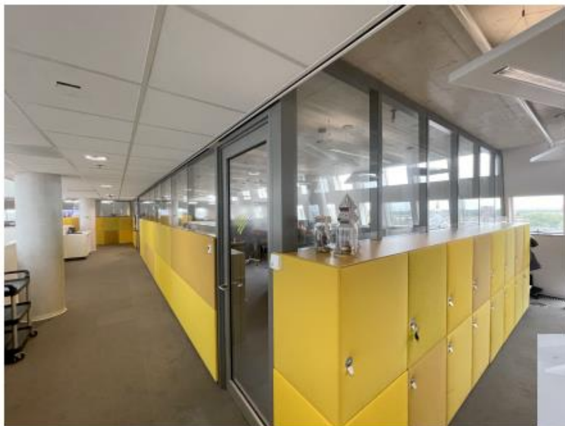
Lockers verwijderen tbv nieuwe werkplekken
