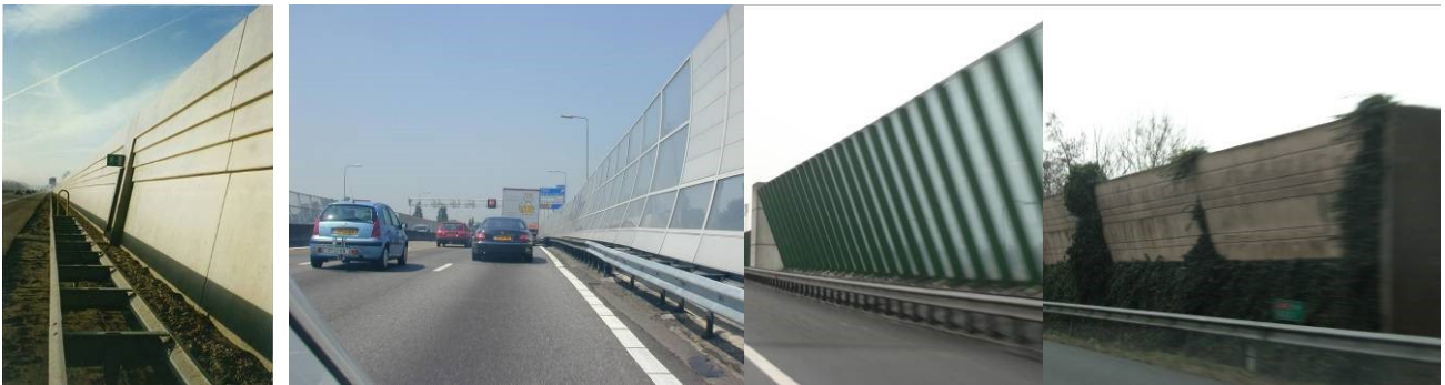
Figuur 5: Voorbeelden van achterover hellende schermen (links) en voorover hellende schermen (rechts).
