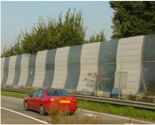
Figuur 10: Links een geluidscherm met een regelmatige wisseling van materiaal. Dit is 1 segment. Rechts: een onregelmatige verandering van materiaal ter plaatse van een viaduct. Dit is een apart segment.
