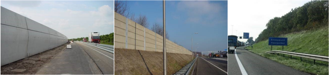
Figuur 3: Voorbeelden van Geluidwerende Voorzieningen. Links een scherm, rechts een wal. De middelste foto toont een combinatie van een grondlichaam met een scherm. Op de linker foto is de barrier tussen rijstroken en het geluidscherm geen GWV.
