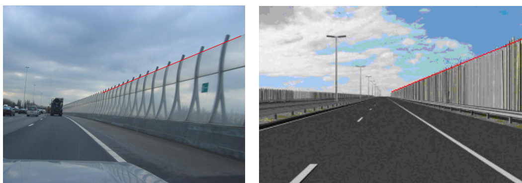
Figuur 12: Voorbeelden van schermen waarbij voor het bepalen van de bovenrand moet worden uitgegaan van een denkbeeldige lijn. Op de foto's is een deel van die lijn in rood aangegeven.
