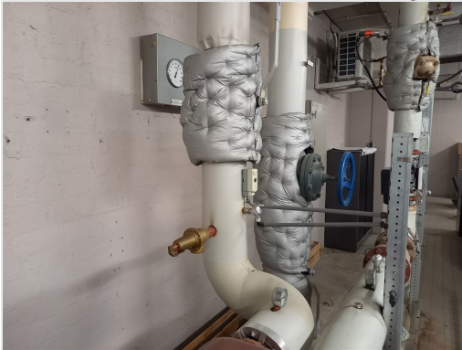
Leidingsisolatie, niet verdacht
