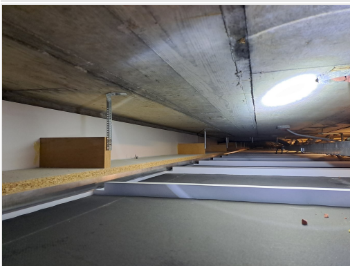
Aftimmering gang, tegen de kantoorunits
