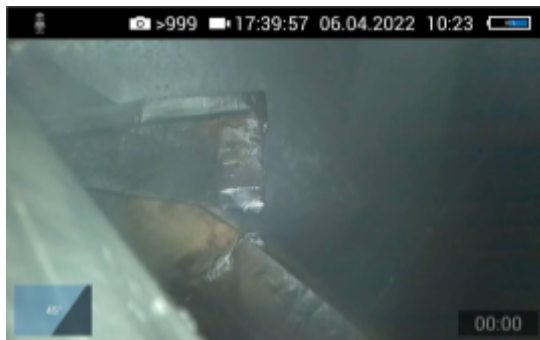
Afbeelding 4 - Loslatend aluminiumtape
