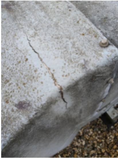
Afbeelding 8 - Scheur in de glasvezel buitenlaag
