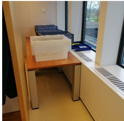
Servomotor afgebroken Pantry staan tafels voor
