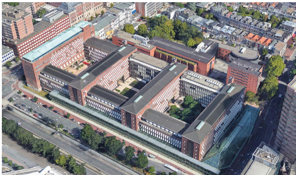
Afbeelding: Positie PVT-panels op het dak van het gebouw Bezuidenhoutseweg 73, Den Haag
