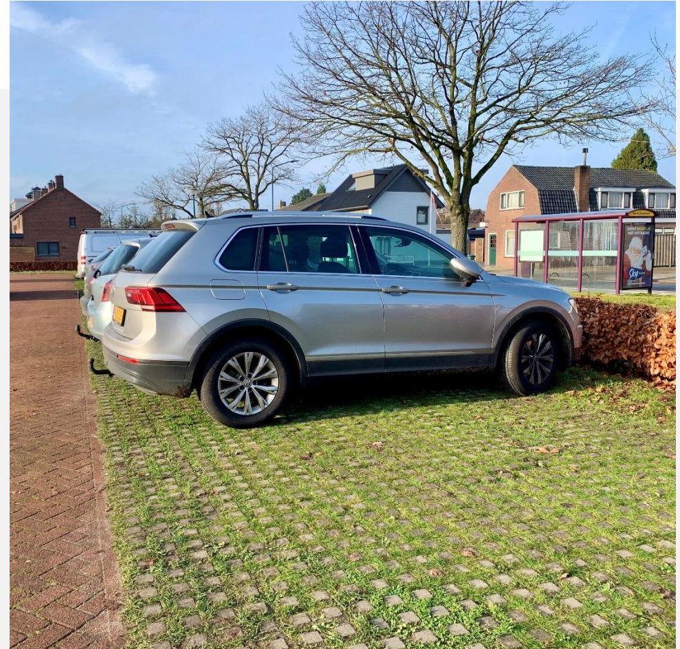
Afbeelding 2 Parkeerplaats met waterdoorlatende tegels aan de Berndijksestraat (Bron: Arcadis)
