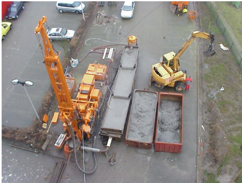
Figuur 4.4 | Voorbeeld van een boorwagen en bijbehorende booropstelling.
