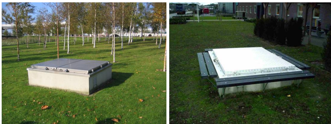
Figuur 4.2 | Voorbeelden van half bovengrondse putbehuizingen.
