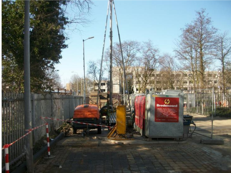
Figuur 4.5 | Werkopstelling tijdens ontwikkelen bronnen.
