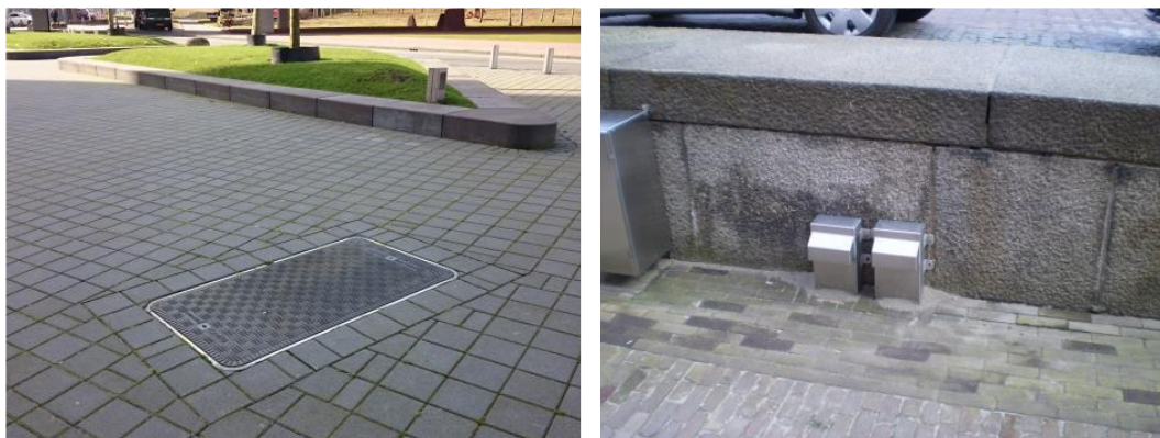
Figuur 4.3 | Voorbeeld van een ondergrondse putbehuizing met ventilatiepaaltjes.
