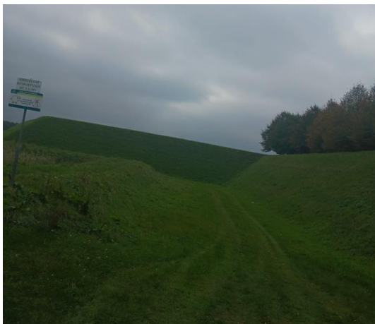
Afbeelding 4. Het beginpunt van het tracé en de dijk waarop een open ontgraving wordt gerealiseerd.
