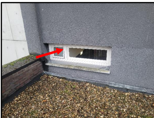
Bron 5/M50: asbesthoudende stopverf in stalen raamvleugels en bovenlichten bouwdeel C
