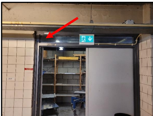
Bron 1/M1: asbesthoudende beglazingskit in bovenlichten
