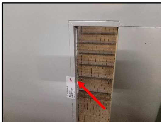
Bron 1/M6: asbesthoudende beglazingskit in binnendeuren
