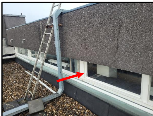
Bron 5/M58: asbesthoudende stopverf in stalen raamvleugels en bovenlichten bouwdeel C
