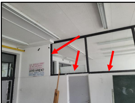
Bron 1/M70: asbesthoudende beglazingskit in binnenkozijnen
