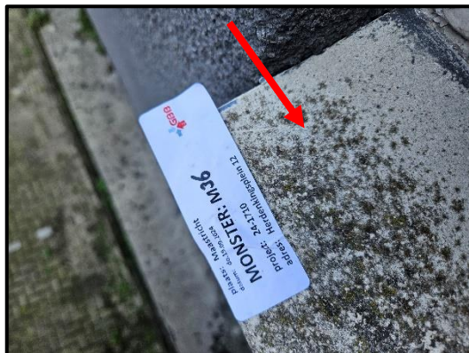
Bron 6/M36: asbesthoudende raamdorpels langs gevelkozijnen bouwdeel C
