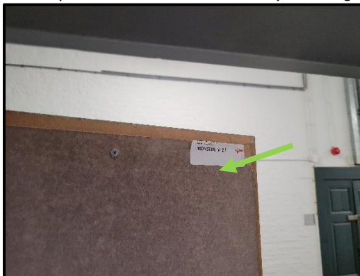
M22 – plaatmateriaal deur gashok is niet asbesthoudend
