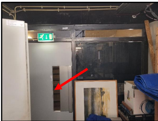
Bron 1/M6: asbesthoudende beglazingskit in binnendeuren
