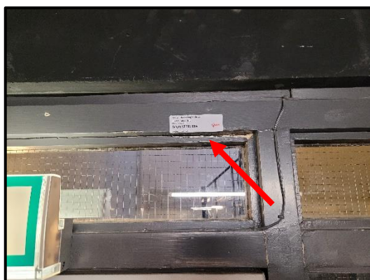
Bron 1/M5: asbesthoudende beglazingskit in bovenlichten
