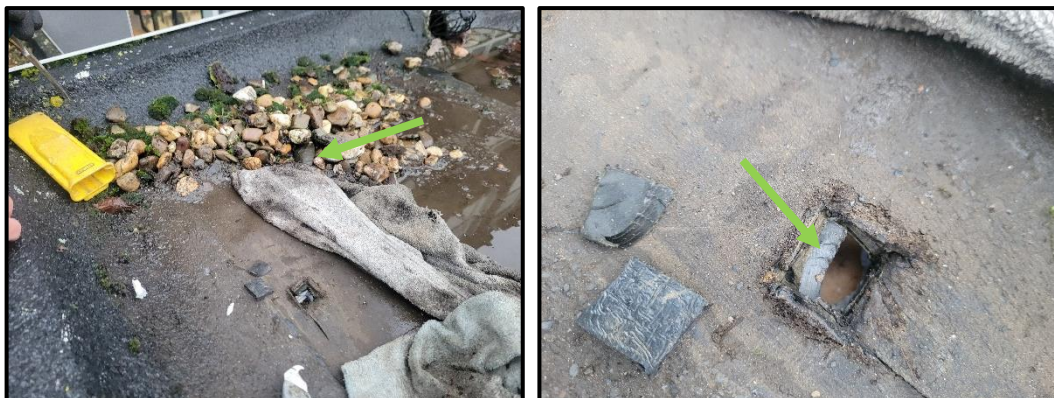
M43 – bitumen dakbedekking is niet asbesthoudend
