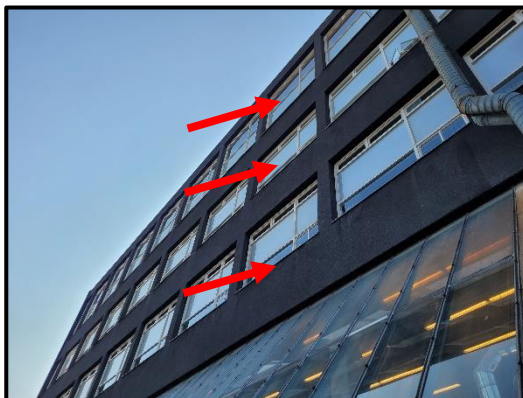
Bron 6/M36: asbesthoudende raamdorpels langs gevelkozijnen bouwdeel C
