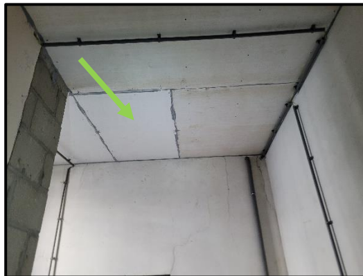
M21 – plaatmateriaal wanden en plafond gashok is niet asbesthoudend
