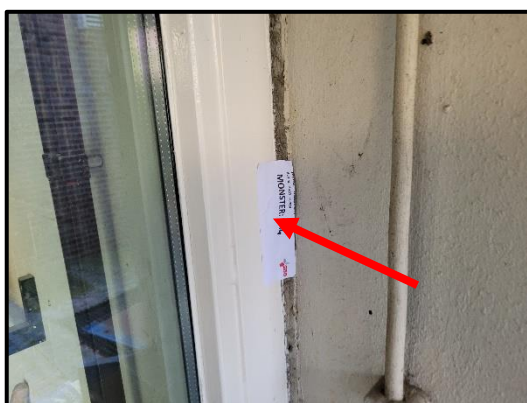
Bron 7/M14: asbesthoudende gevelkit rond gevelkozijnen
