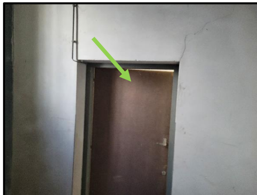
M21 – plaatmateriaal wanden en plafond gashok is niet asbesthoudend
