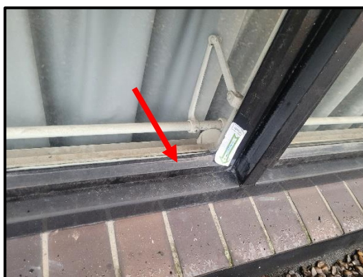
Bron 5/M45: asbesthoudende stopverf in raamvleugels en bovenlichten gevelkozijnen bouwdeel B
