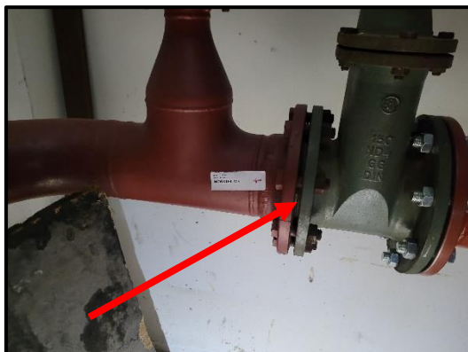
Bron 3/M7: asbesthoudende pakkingen tussen flens van de waterleiding (rest pakkingen zijn van rubber)
