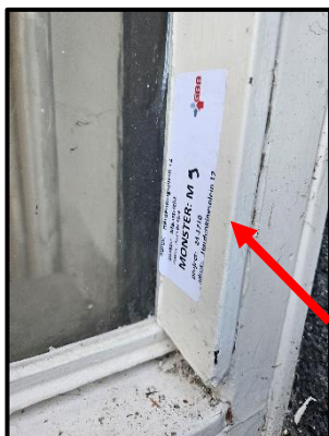
Bron 4/M9: asbesthoudende beglazingskit in gevelkozijnen bouwdeel C
