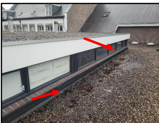
Bron 5/M45: asbesthoudende stopverf in raamvleugels en bovenlichten gevelkozijnen bouwdeel B
