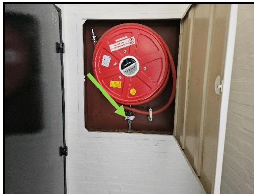
M35 – pakking kraantje brandslanghaspel is niet asbesthoudend
