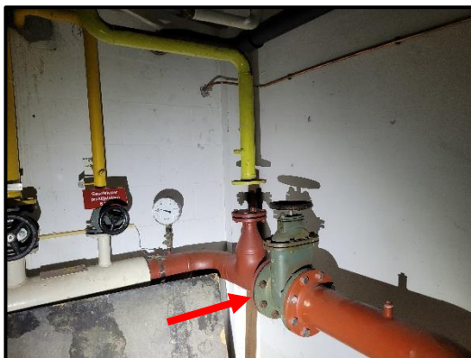
Bron 3/M7: asbesthoudende pakkingen tussen flens van de waterleiding (rest pakkingen zijn van rubber)
