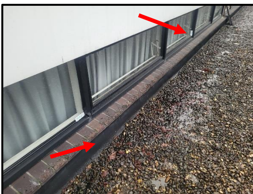
Bron 5/M44: asbesthoudende stopverf in raamvleugels en bovenlichten gevelkozijnen bouwdeel B
