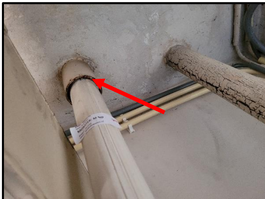
Bron 9/M40: asbesthoudend koord in doorvoer plafond
