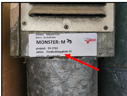
Bron 8/M39: asbesthoudende kit op ventilatiekanalen
