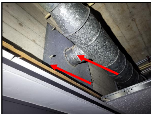
Bron 8: asbesthoudende kit op ventilatiekanalen
