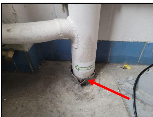
Bron 9/M71: asbesthoudend koord in vloerdoorvoer cv-leiding
