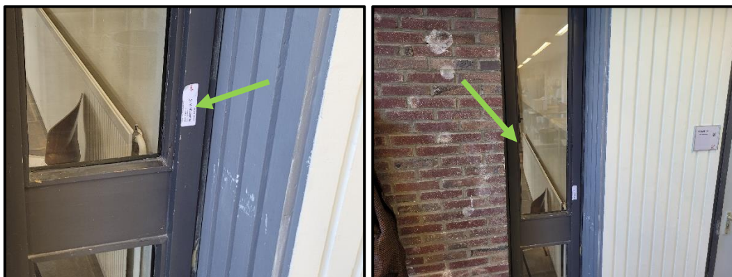
M15 – dit monster bleek na analyse niet asbesthoudend
