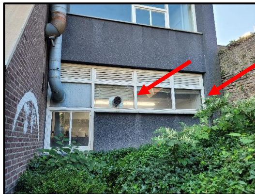
Bron 4/M9: asbesthoudende beglazingskit in gevelkozijnen bouwdeel C
