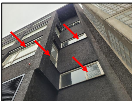
Bron 5/M32: asbesthoudende stopverf in stalen raamvleugels en bovenlichten bouwdeel C
