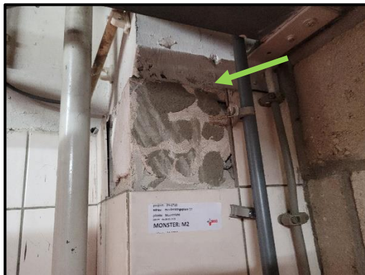
M2 – tegellijm en -voegsel wanden techniekruimte souterrain bouwdeel D
