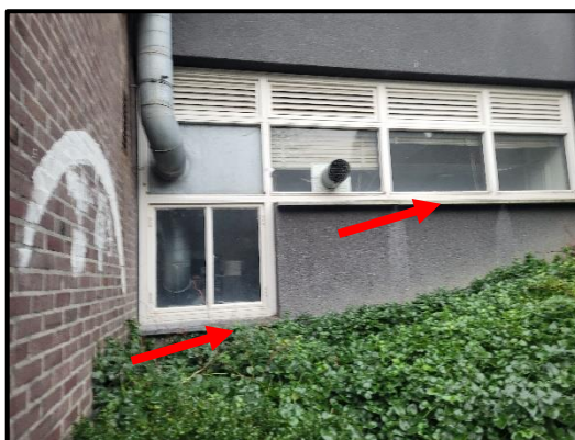
Bron 6: asbesthoudende raamdorpels langs gevelkozijnen bouwdeel C
