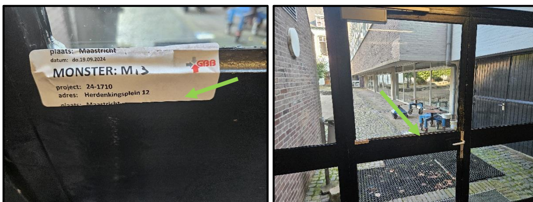
M13 – dit monster bleek na analyse niet asbesthoudend
