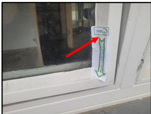
Bron 5/M50: asbesthoudende stopverf in stalen raamvleugels en bovenlichten bouwdeel C
