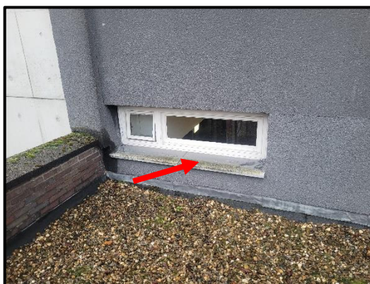
Bron 6: asbesthoudende raamdorpels langs gevelkozijnen bouwdeel C
