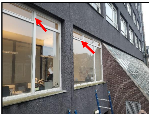
Bron 5: asbesthoudende stopverf in binnenpui en bovenlichten gevelkozijnen bouwdeel C
