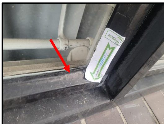
Bron 5/M44: asbesthoudende stopverf in raamvleugels en bovenlichten gevelkozijnen bouwdeel B
