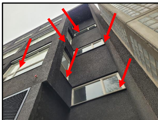
Bron 6: asbesthoudende raamdorpels langs gevelkozijnen bouwdeel C
