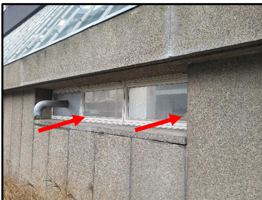
Bron 5/M10: asbesthoudende stopverf in stalen raamvleugels en bovenlichten bouwdeel C
