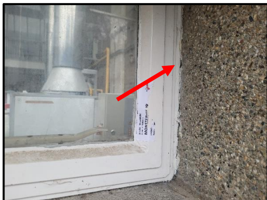
Bron 5/M10: asbesthoudende stopverf in stalen raamvleugels en bovenlichten bouwdeel C
