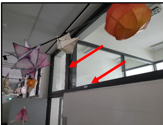
Bron 1/M69: asbesthoudende beglazingskit in binnenkozijnen
