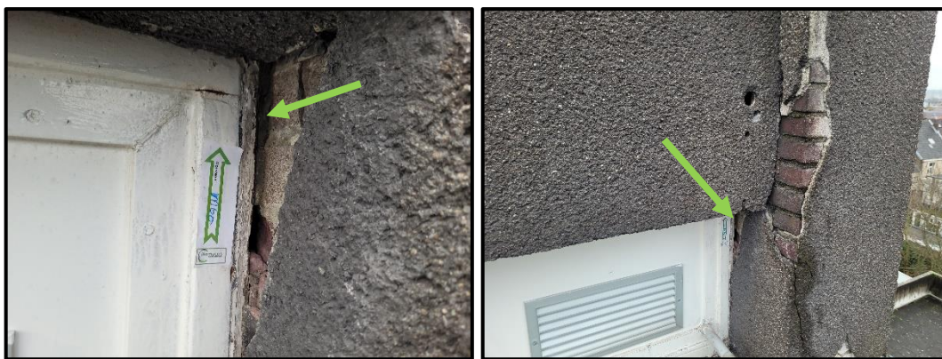
M60 – dit monster bleek na analyse niet asbesthoudend
