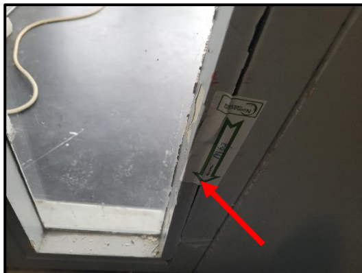
Bron 1/M67: asbesthoudende beglazingskit in zijlichten
