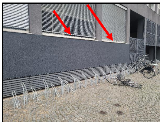
Bron 6: asbesthoudende raamdorpels langs gevelkozijnen bouwdeel C
