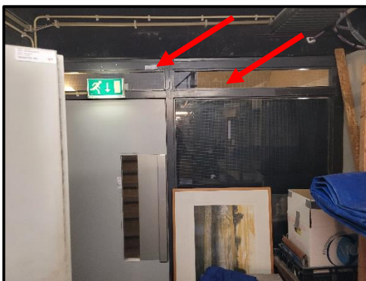
Bron 1/M5: asbesthoudende beglazingskit in bovenlichten
