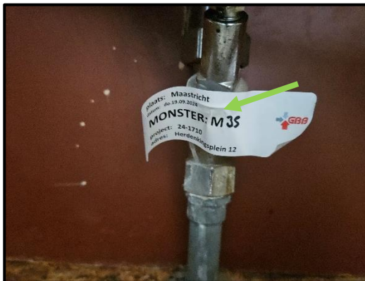
M35 – pakking kraantje brandslanghaspel is niet asbesthoudend
