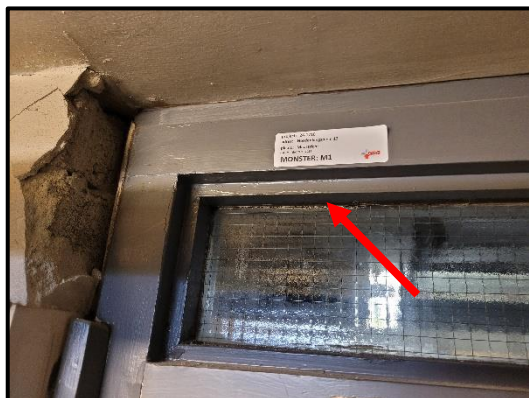
Bron 1/M1: asbesthoudende beglazingskit in bovenlichten
