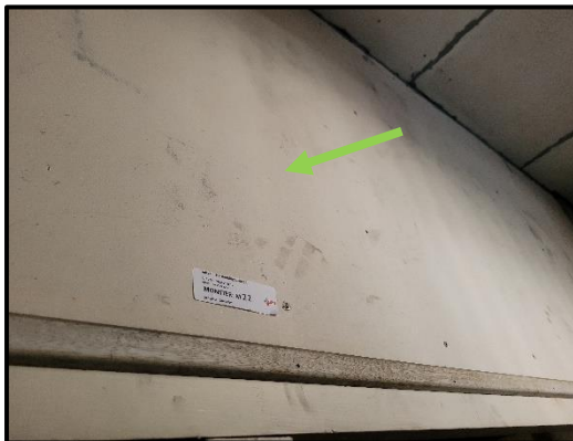
M21 – plaatmateriaal wanden en plafond gashok is niet asbesthoudend
