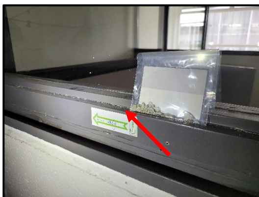
Bron 1/M69: asbesthoudende beglazingskit in binnenkozijnen
