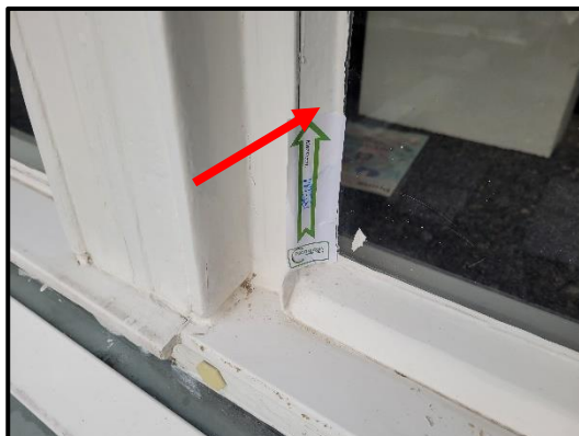
Bron 5/M58: asbesthoudende stopverf in stalen raamvleugels en bovenlichten bouwdeel C
