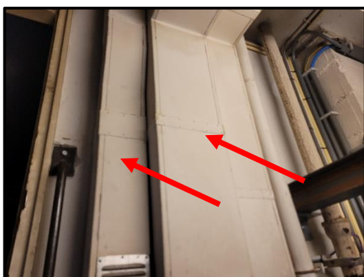
Bron 8: asbesthoudende kit op ventilatiekanalen
