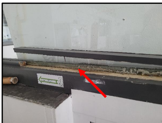
Bron 1/M70: asbesthoudende beglazingskit in binnenkozijnen
