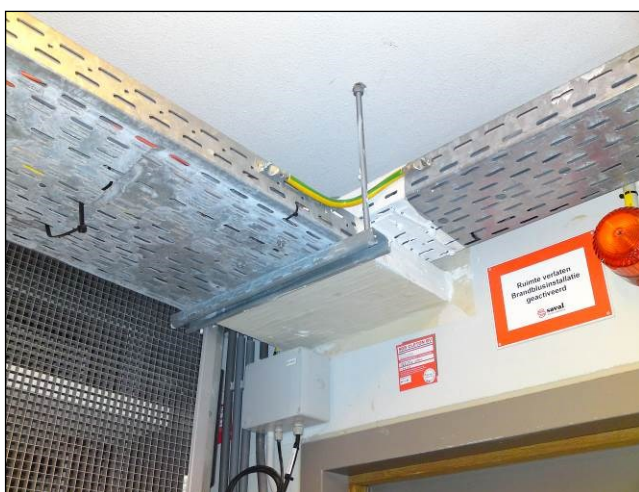
C Koppeling gootsecties bij kruising goten
