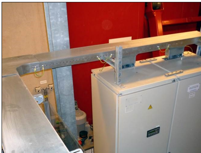
A Koppeling kabelgoot – apparatuurkast
