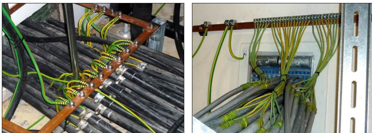
Figuur 11.2 Voorbeelden kabelinvoer, aansluiting armering op ringleiding
