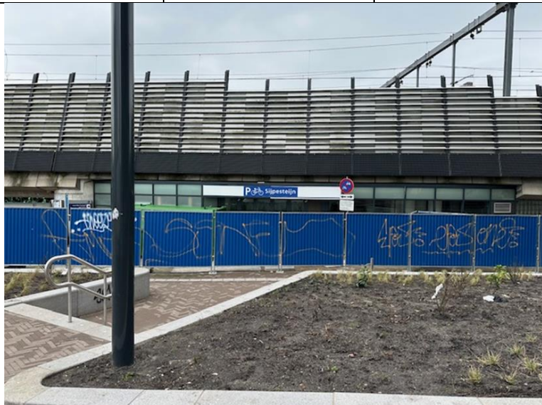
Bron: beeldbank gemeente Utrecht Als voorbeeld de afgesloten fietsparkeergarage Sijpesteijn
