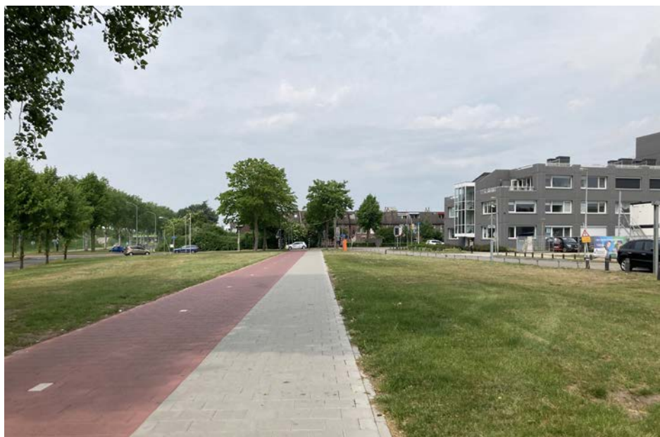
Afronden hoek Stationsweg en Agorabaan en aansluiten bij bestaande bebouwing
