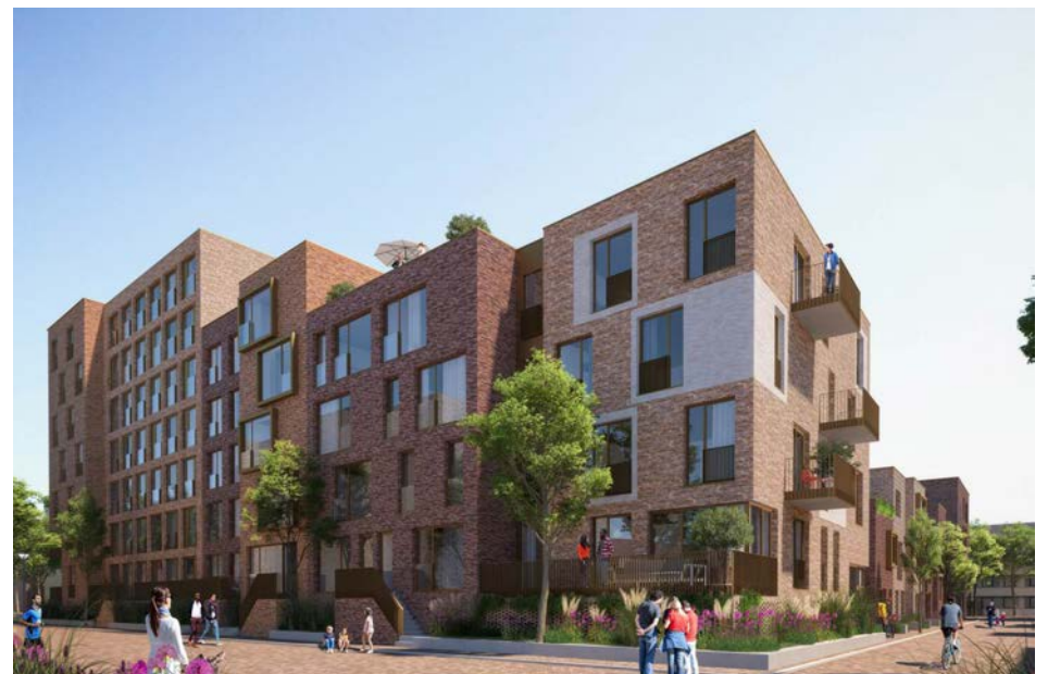
Impressie bouwveld III met halfverdiept parkeren aan de Waagstraat
