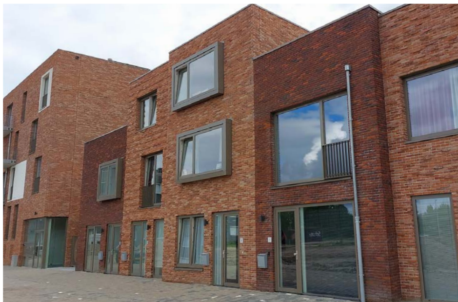
Impressie huidige bebouwing op bouwveld III
