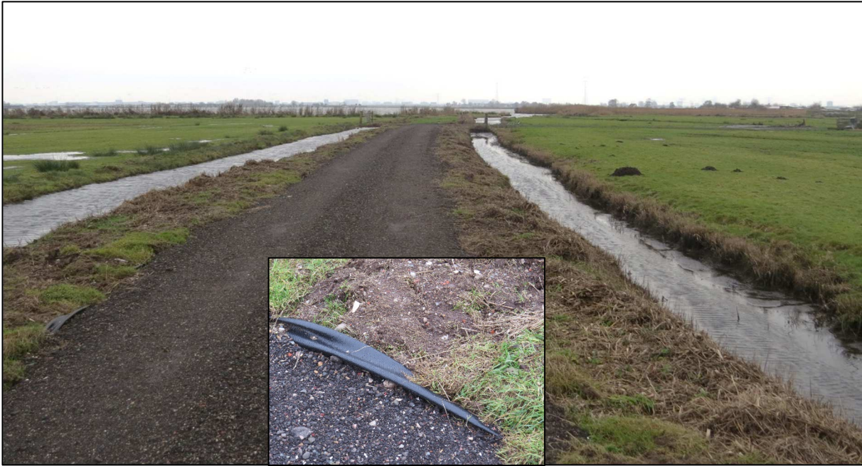
Het huidige, reeds vernieuwde, beheerpad in De Munt bestaande uit menggranulaat op geotextiel. Hier zal nog een laagje bagger van 5 cm worden aangebracht waarna het pad weer begroeid zal raken met gras.
