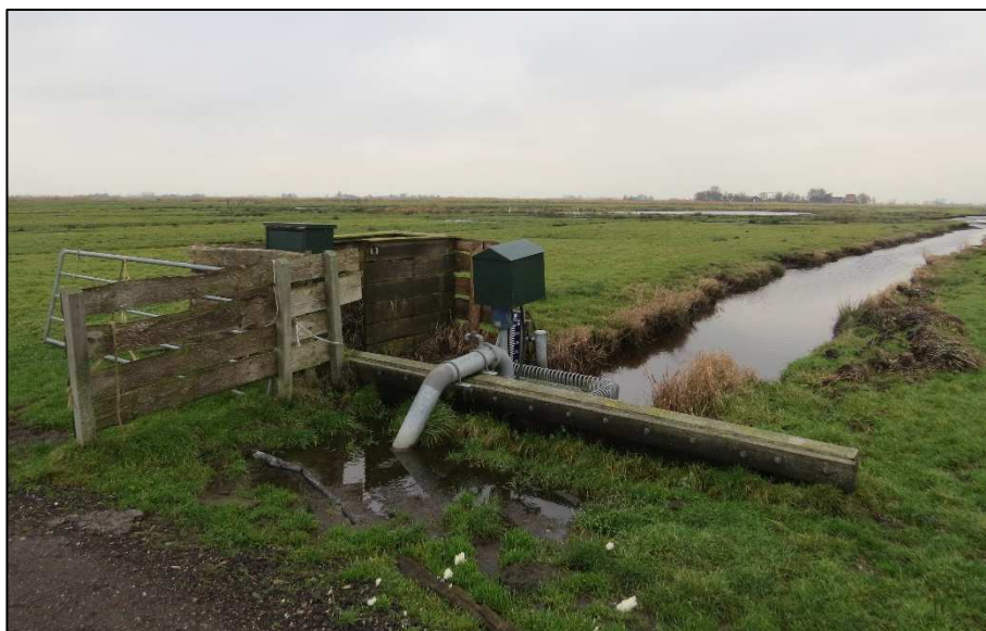
Kunstwerk ten behoeve van onderbemaling in combinatie met jachthut in De Munt.
