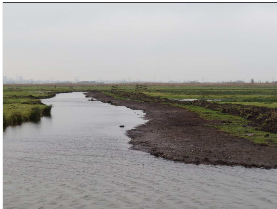
Voorbeeld van kadeherstel en aanleg NVO met 2-3 meter breed maaibaar talud in De Munt.
