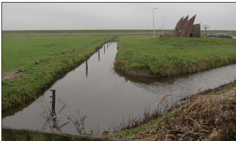
Locatie in De Kinsel waar kadeherstel zal plaats vinden en een NVO (onderwater oever) aangelegd zal worden (linkerkant sloot).
