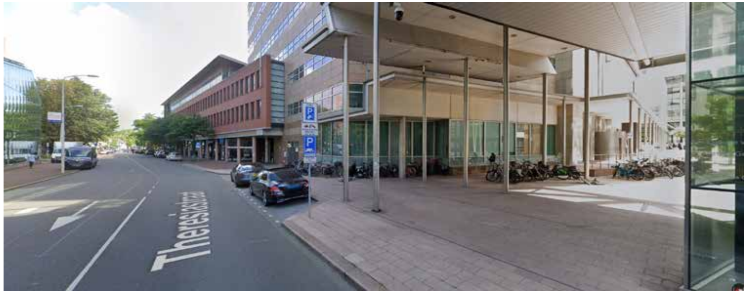
De plintlaag kenmerkt zich door blinde gevels, garage-entrees en weinig belevingswaarde, gebruikswaarde en omgevingswaarde
