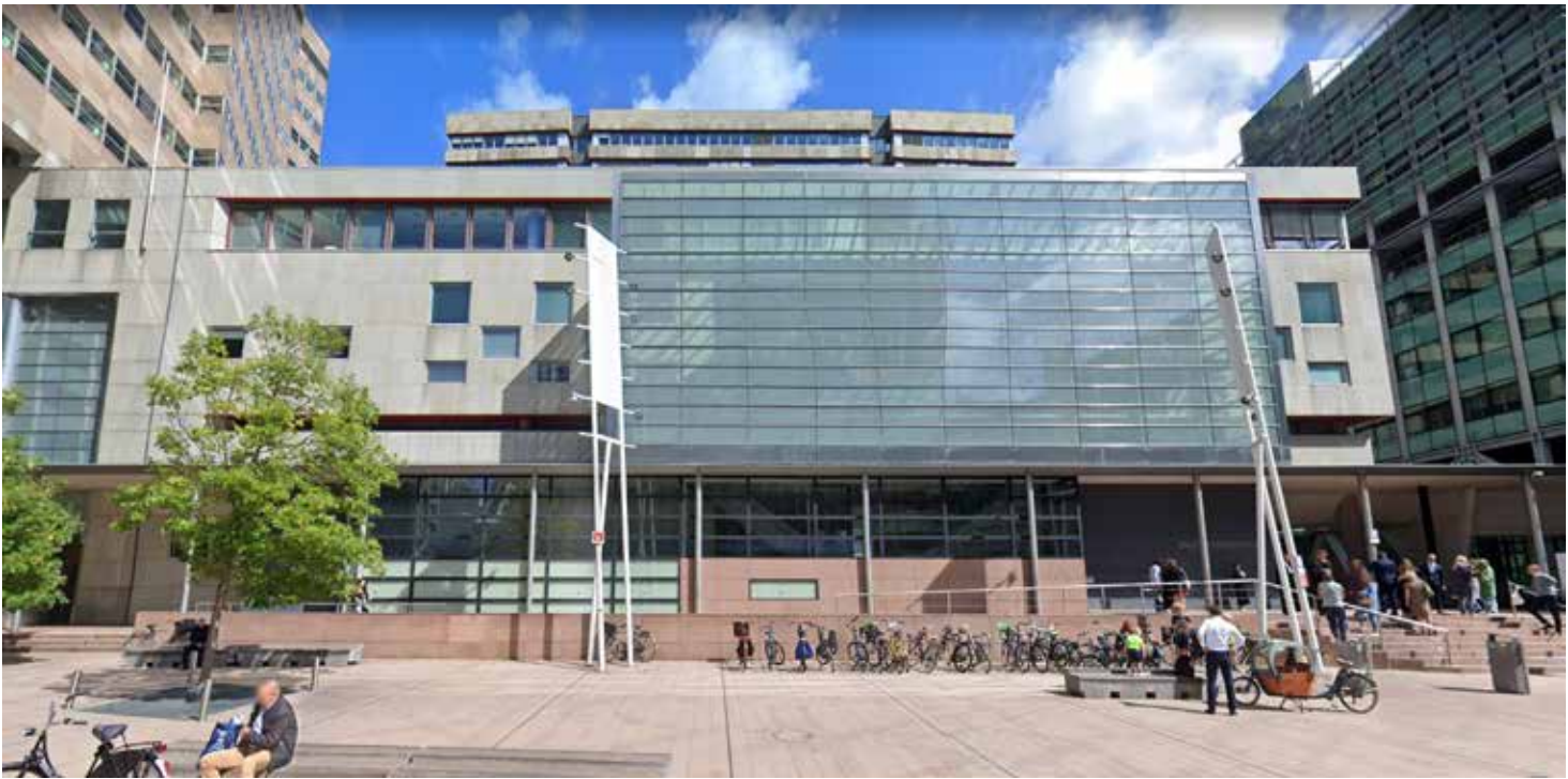
De plintlaag is rommelig, biedt geen zicht naar binnen en de entree is moeilijk vindbaar
