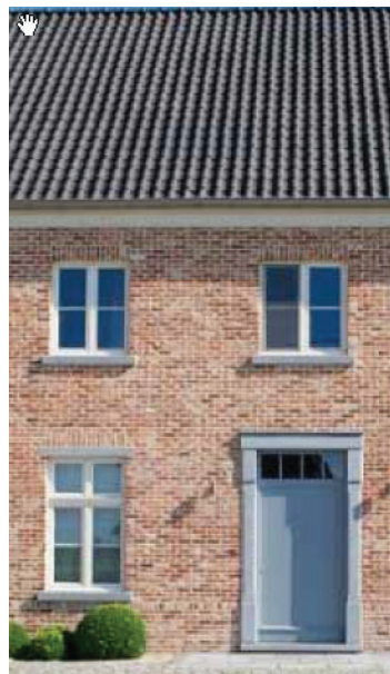
Nuances in kleurenpalet van bakstenen gevels
