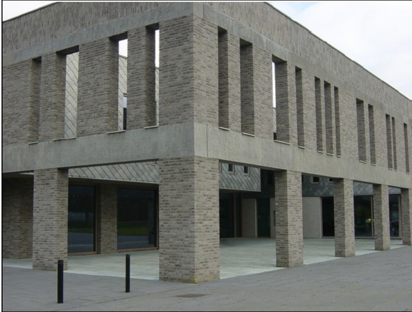
Pilaar behorende bij gebouw
