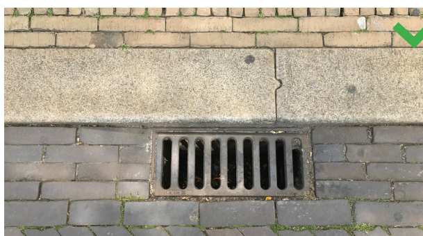
Detail van een goede toepassing van een valkolk in molgoot.
