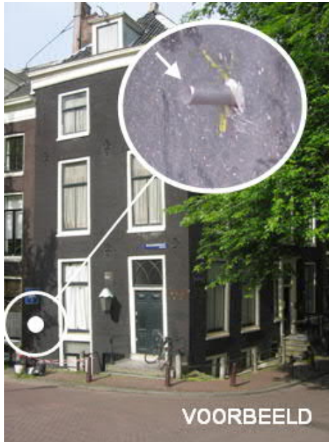
Figuur 8 Voorbeeld hoogtemeetbout
