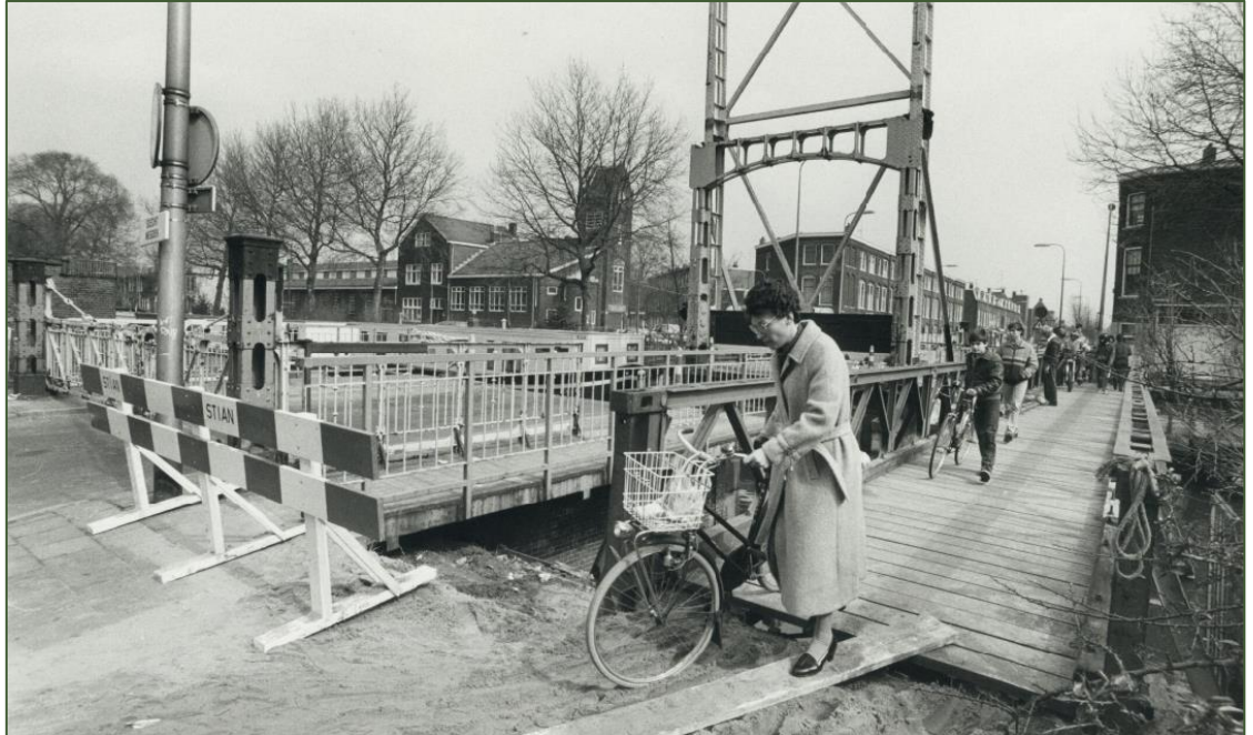
Afbeelding van de hulpbrug langs de Ouderijnbrug over de Oude Rijn, tijdens de werkzaamheden t.b.v. de vernieuwing van de brug in 1983. 25
