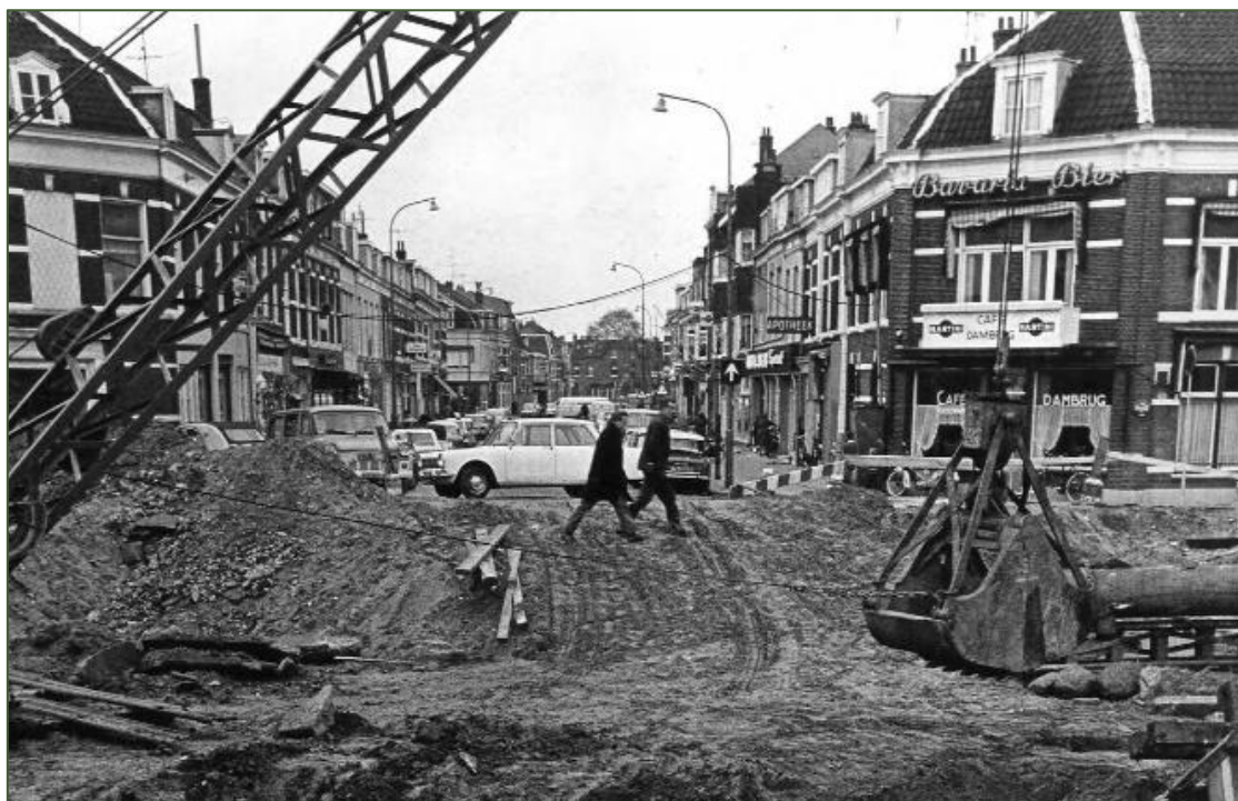
Werkzaamheden op de overkluisde Leidsche Rijn (voormalige Dambrug) in 1968. 14
