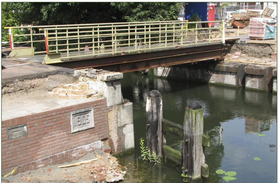
De noodbrug over de Oude Rijn tijdens de restauratie van de Ouderijnbrug in 2008. 26
