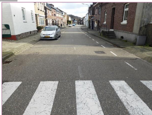
Foto 41: vanaf Sint Remigiusstraat (overgang oppervlakbehandeling)
