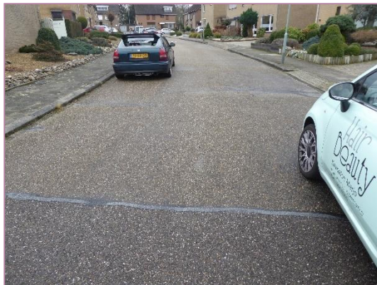
Foto 23: vanaf huisnummer 16 (overgang deklaag)
