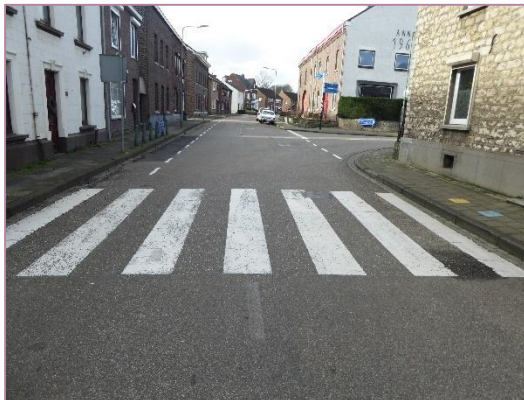
Foto 40: vanaf Sint Remigiusstraat (overgang oppervlakbehandeling)
