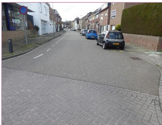
Foto 42: vanaf Dr. Ottenstraat (overgang asphalt-bss)
