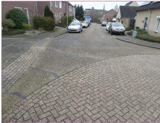
Foto 22: vanaf overgang asfalt/bss
