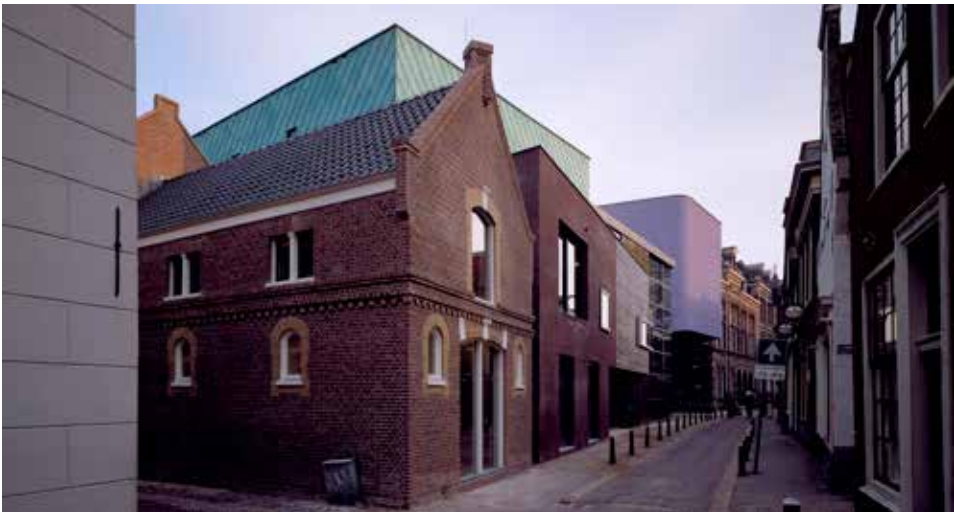
kantoren, zalen en foyer zijn zichtbaar aan de straat
