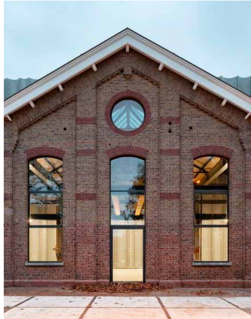
Referenties: raam doorgezet naar straatniveau tbv een deur voor bijvoorbeeld een vluchtroute
