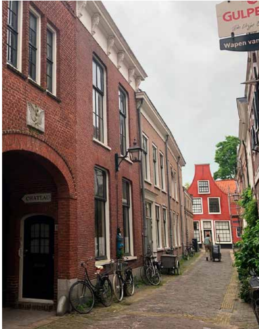
Bestaand pand Korte Begijnestraat 12 met 2 ramen met borstwering
