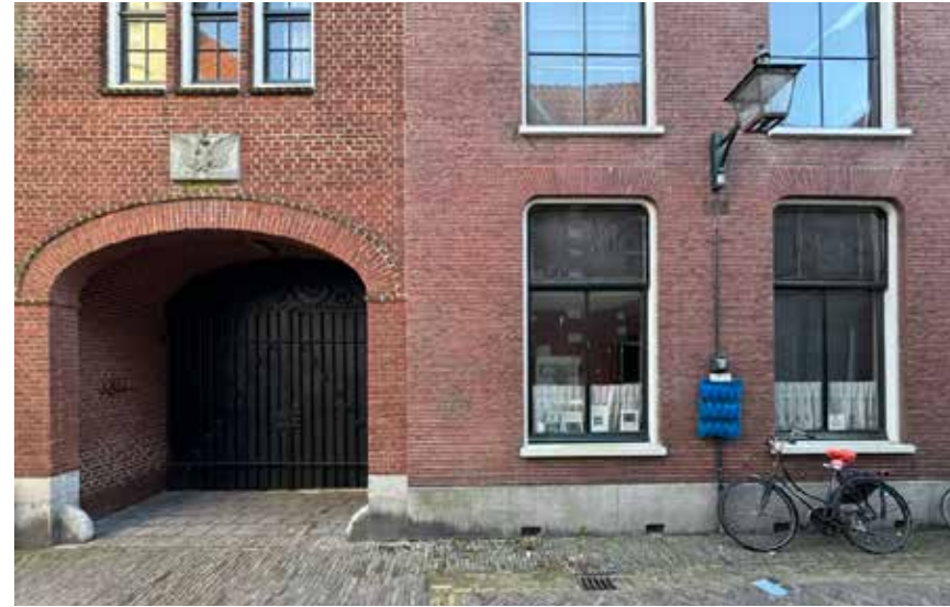
poortgebouw met gesloten hekwerk
