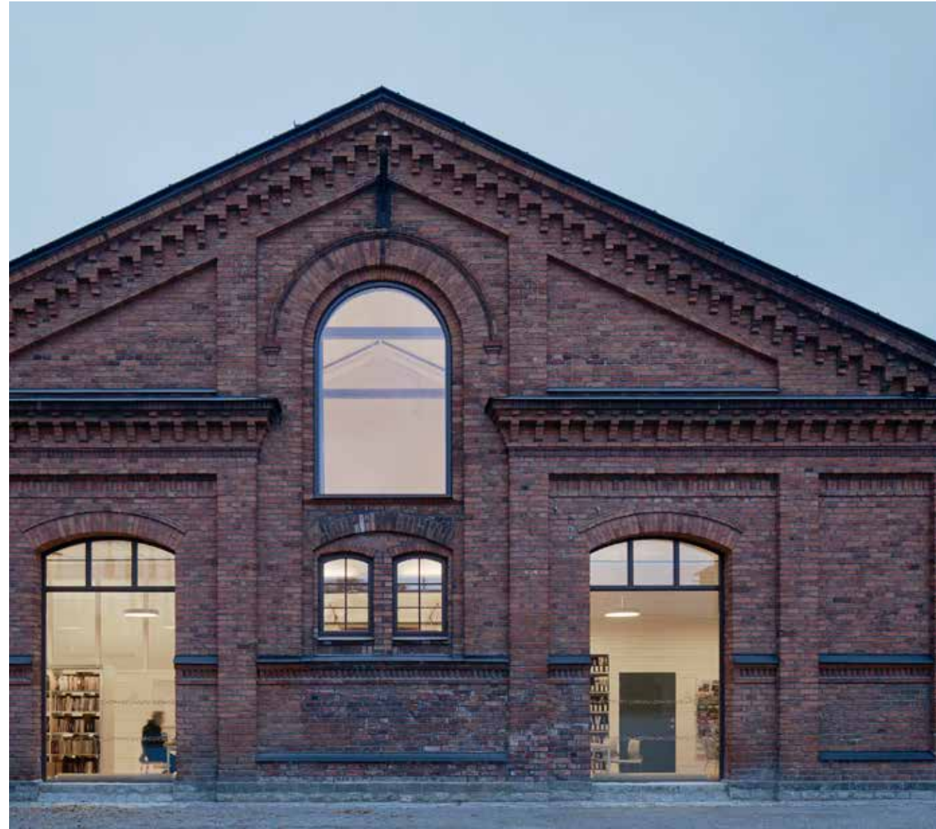
Referenties: nieuwe pui in bestaande gevelopening
