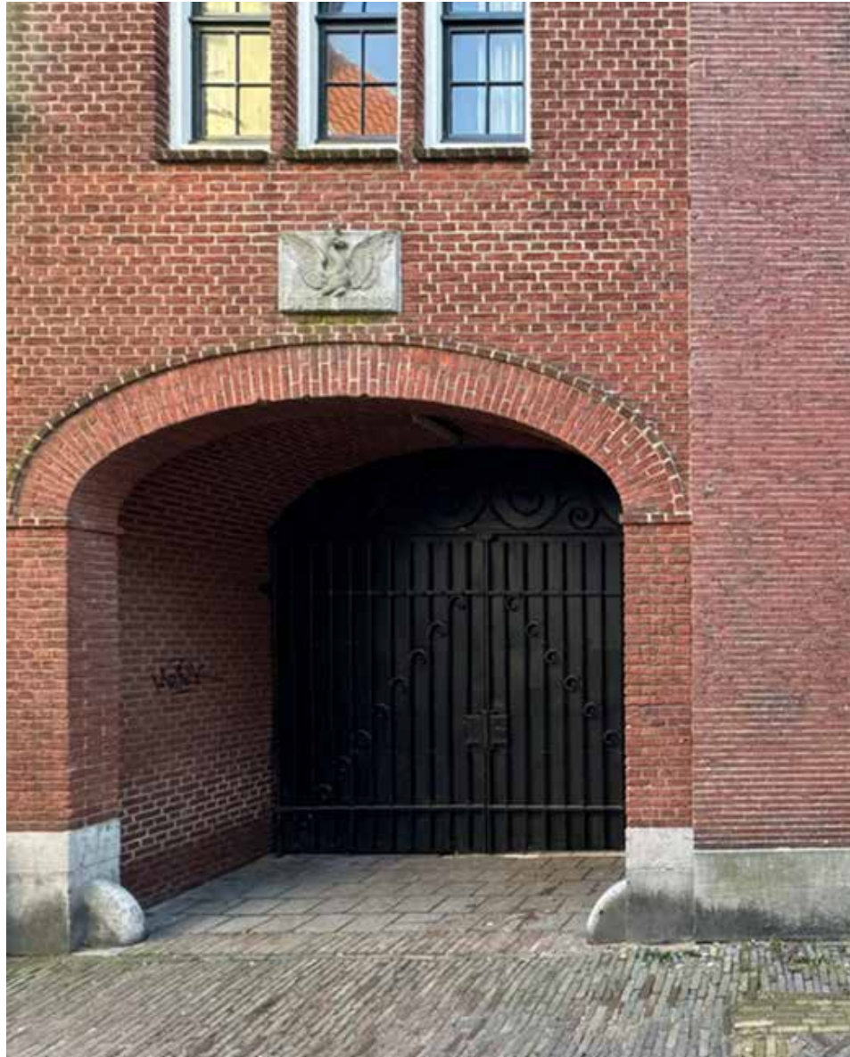
Bestaand poortgebouw met gesloten hekwerk
