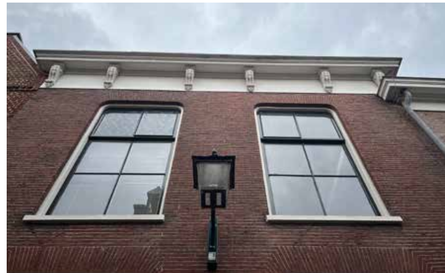
raamverdeling, vormgeving kozijnen, gedetailleerde daklijst en geveldetails: verlichting & siersteen
