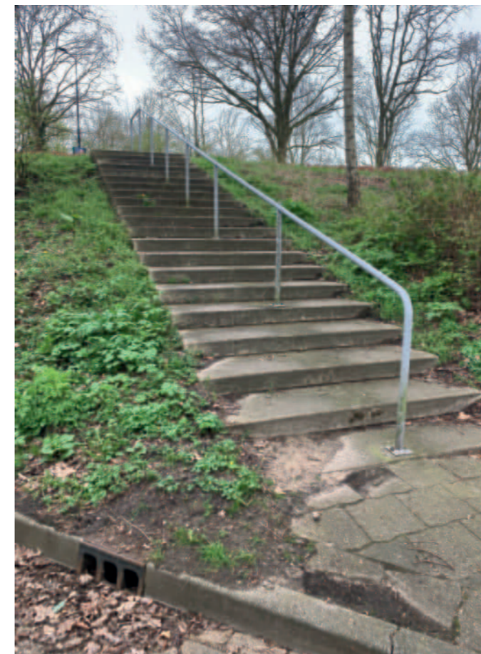
Huidige trap vanaf talud viaduct naar Willestee
