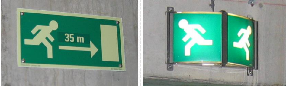
Figuur 3: Vluchtwegverlichting
