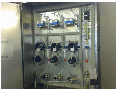
Figuur 6: Gasdetectie vloeistofafvoerkelder
