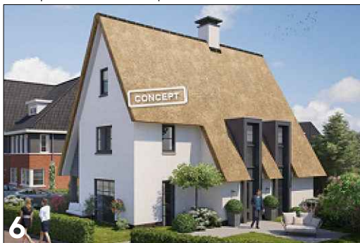
6 Aandacht voor hoekoplossing door de toepassing van een opbouw met doorlopende dakconstructie
