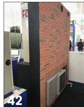
Buitenunit inpandig in gevel verwerkt
