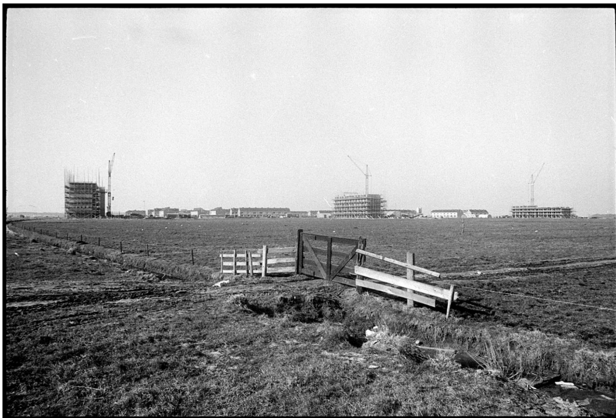
Figuur 7. Bouw van de flats aan de Maerelaan (1969). Fotopersbureau De Boer, NL-HlmNHA_1478_06949K00_07, CC0.
