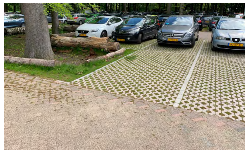
Halfverharding op het parkeerterrein vermindert de hoeveelheid water die van de bestrating af loopt bij een bui
