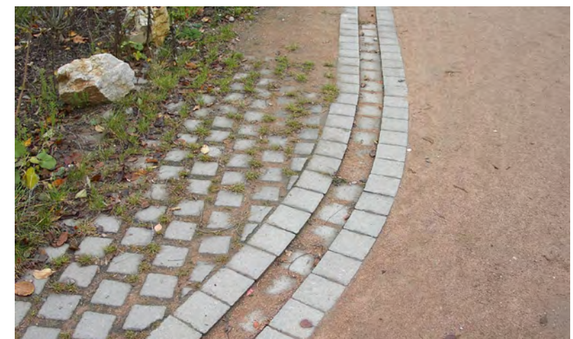
Goten in de bestrating maken de afwatering zichtbaar
