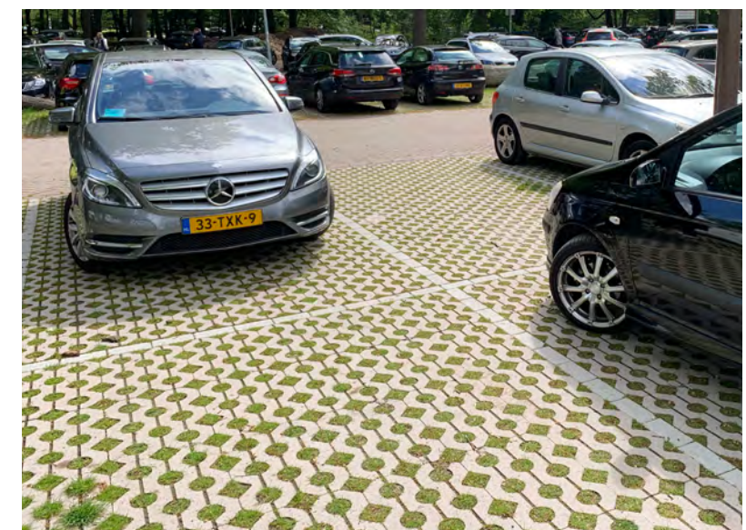
Spiegels van parkeerplaatsen aanleggen met halfverharding en grasmengsel. (let op: geen biggenruggen toepassen, dan wordt het onderhoud bemoeilijkt). Hierdoor kan een deel van het water beter infiltreren (in combinatie met krattensysteem). Uit te werken als principedetail.
