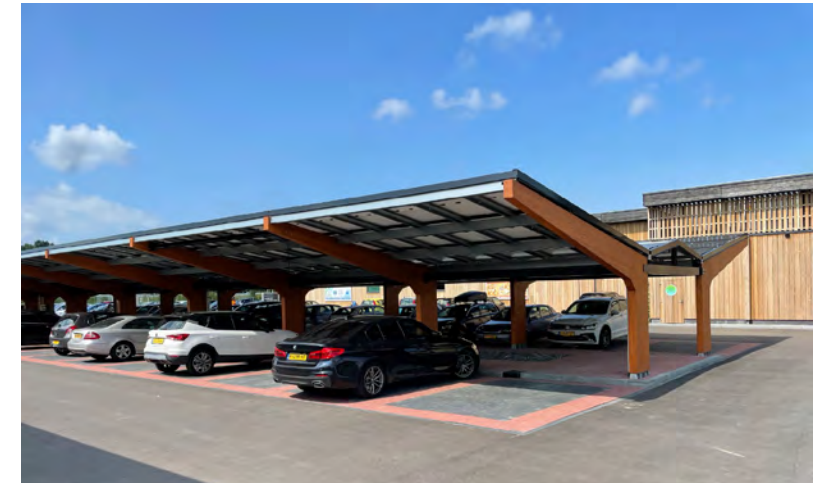
Zonnepanelen boven parkeerplekken wekken energie op (ook voor laadpalen) en geven schaduw op de auto's
