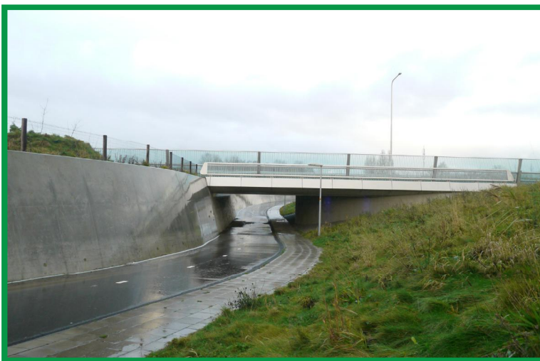
De grondkerende wand en de talud-bekleding zijn als een doorlopend 'lint' ontworpen. Alle elementen vormen één samenhangend geheel en zijn zorgvuldig in het landschap ingepast. RWS onderdoorgang N9 bij Schoorlham
