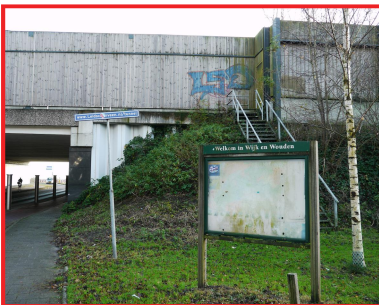
De informatieborden zijn slecht onderhouden en niet eenduidig en samenhangend ontworpen. Hierdoor wordt de rommelige en onoverzichtelijke indruk versterkt. RWS onderdoorgang A4 bij Leidscheveen
