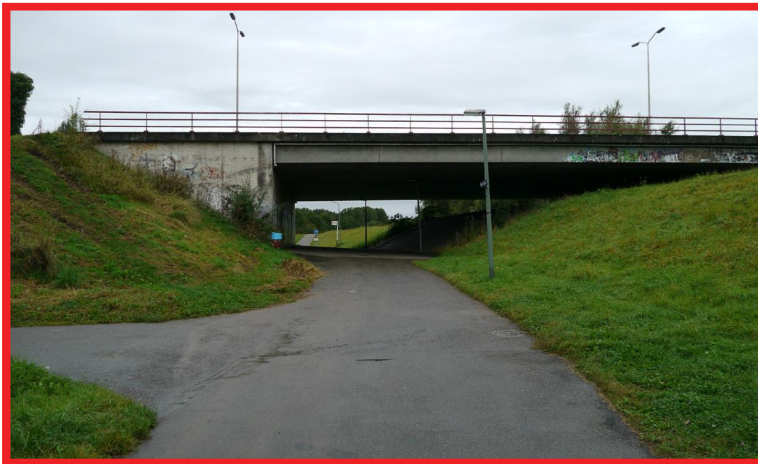
De kruising van de fietsverbinding en de autoweg is zonder overweging voor de ervaring vanuit de omgeving uitgevoerd. Voldoende verlichting en overzicht ontbreken. RWS Wantijbrug Dordrecht
