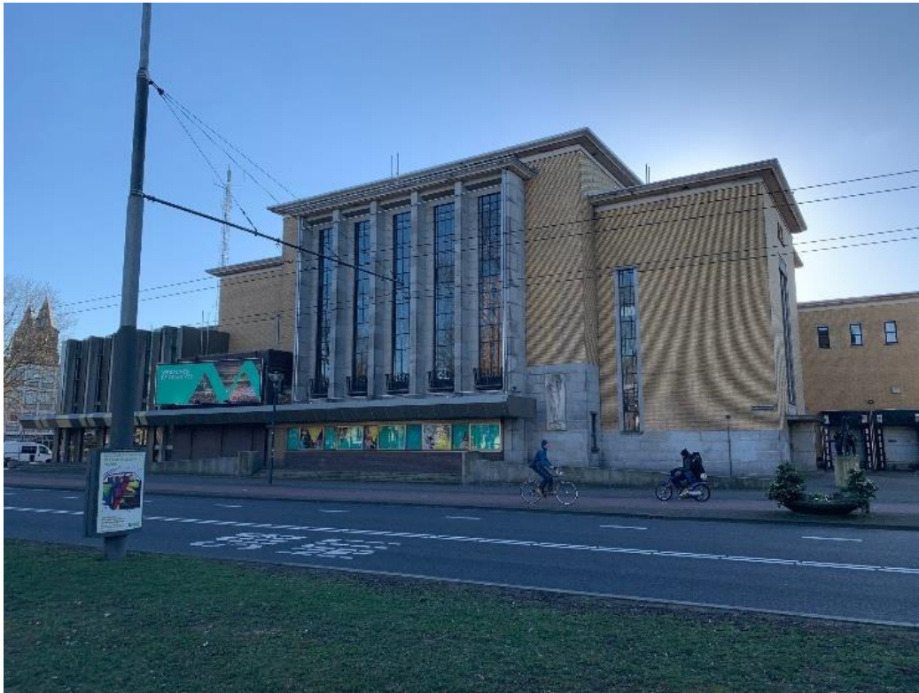
Stadstheater voor de sloopwerkzaamheden
