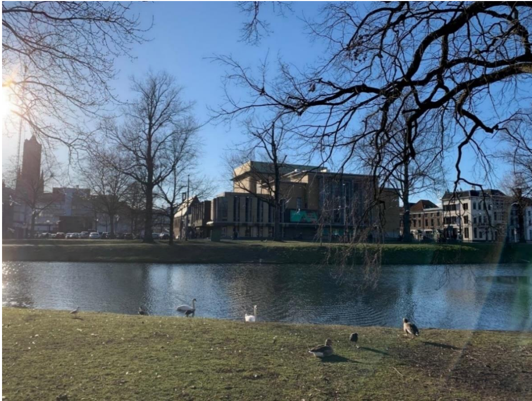
Stadstheater voor de sloopwerkzaamheden, met op de voorgrond de Lauwersgracht
