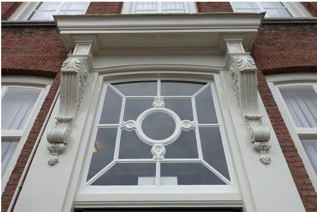
De bovenzijde van het hoofdgestel van de entree. De consoles en de kroonlijst zijn rond 1830 geplaatst. Het bovenlicht is in 1950 aangebracht. De hoogte van het kalf wijkt geheel af van de die van de wisseldorpels van de vensters. Blijkbaar zag men in 1963 geen noodzaak om dit ongedaan te maken.
