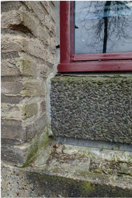
Links een detail van de onderzijde van een venster. De dikke kitnaad is in 1980 aangebracht toen het kozijn en betonpaneel werden vernieuwd. De betonnen band eronder met erin aangebracht een lekgoot stamt uit 1963. Rechts de gevel van het tussenlid. Ook hier zijn de kozijnen en panelen vernieuwd.
