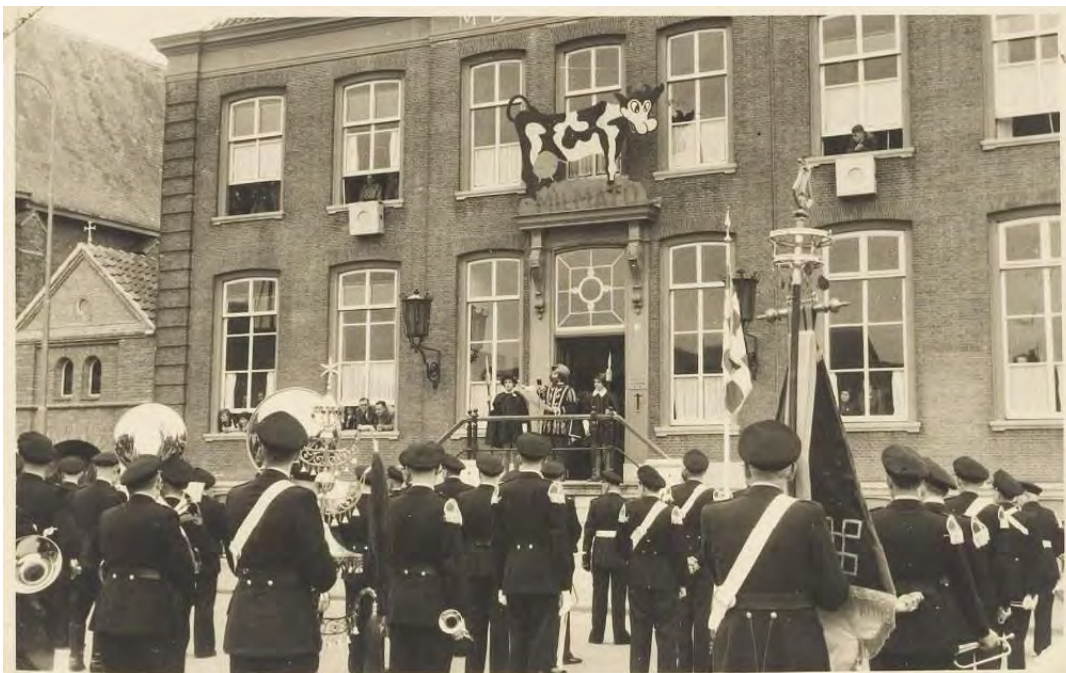
Foto uit 1954 bij gelegenheid van het 360-jarig bestaan van de veemarkt (WBA Jan Sturm, RAW014015432). De bovenlichten met zwikken in de middenrisaliet zijn verwijderd. Het bovenlicht boven de entree is vergroot en de deuren zijn dus ingekort. De indeling van de vensters in de andere traveeën lijkt ongewijzigd.
