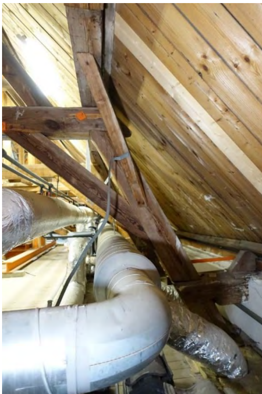
Links de kapvoet aan de zijde van de voorgevel met blokkeel en aangepaste ondersteuning van de goot. Rechts het merk CC.
