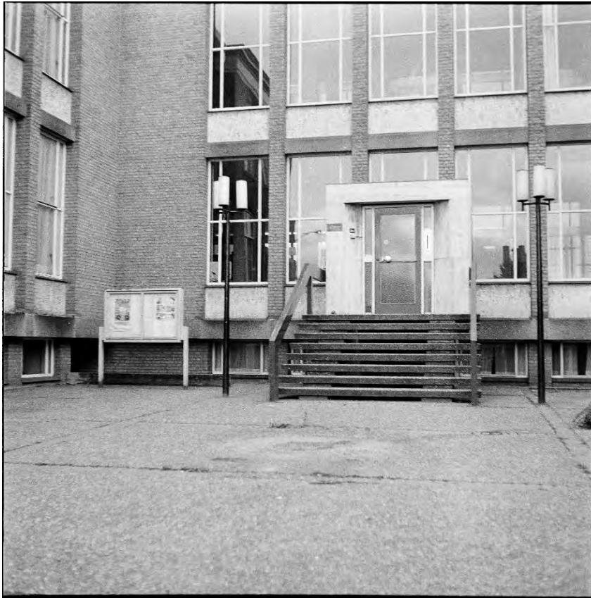
Links de entree tot het nieuwe bouwdeel (1960-1970, C. Th. Lohmann, SAB CLO260111). De architectuur van de gevels is vrij sober met metselwerk en onder de vensters betonnen elementen. De stalen vensters werden in die periode veelvuldig toegepast. De trap van betonnen treden op twee liggers past hier goed bij. Links van de trap ligt de toegang tot de kelder.
