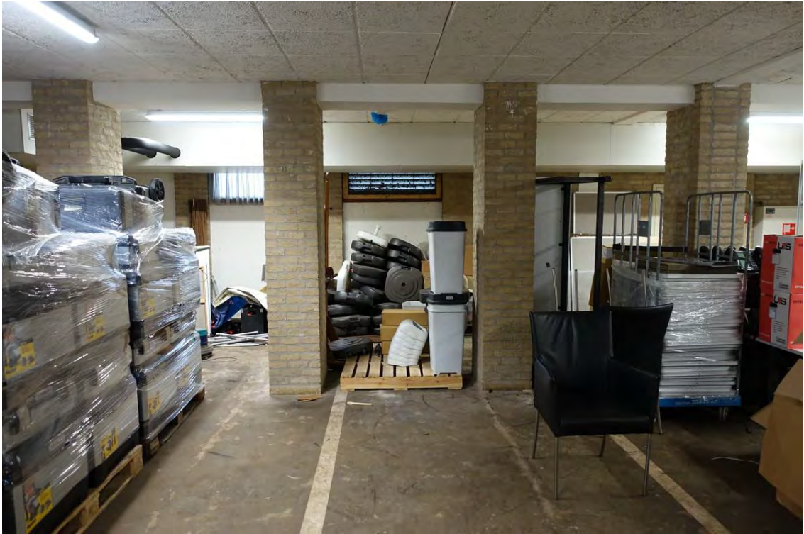
De kelder van bouwdeel 1963. Aan de linkerkant is er een deel afgescheiden waarin technische installaties staan. De vloer is van beton, de wanden gestuct en het plafond van gewapend beton is met houtwolcement platen bekleed. Deze dateren waarschijnlijk uit 1963, toen ze al veelvuldig werden toegepast.
