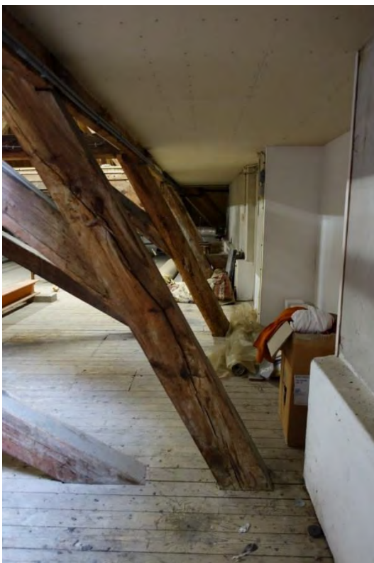
Links de aanheling van het tussenlid op de kapconstructie. Hier zijn de muurplaat en borstwering verwijderd. Rechts zicht op de drie balken die op de dekbalk liggen en waar het torentje oorspronkelijk op stond.
