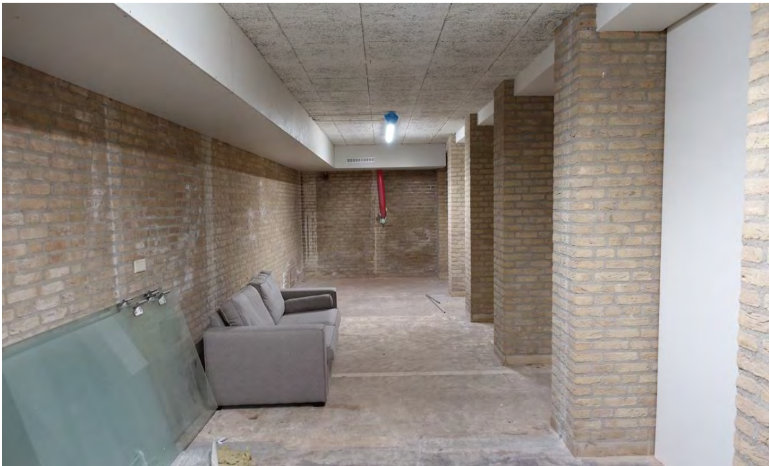
De linkerkant van de kelder van bouwdeel 1963. De betonnen vloeren en de ommetselde kolommen zijn sinds 1963 niet gewijzigd. De kolommen geven de structuur van de gang aan die de ruimtes er rechts (achter) van ontsloot. Op de begane grond en de verdiepingen is het metselwerk in 1980 (of later) gepleisterd.
