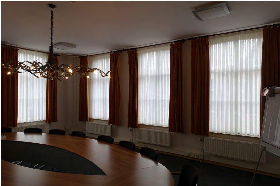
De zaal op de verdieping van bouwdeel 1776 aan de linkerzijde. De afwerkingen zijn gelijk aan die op de begane grond. De drie vensters aan de rechterzijde zijn in 1963 toegevoegd. Onder de stoffering is de eiken vloer nog aanwezig.
