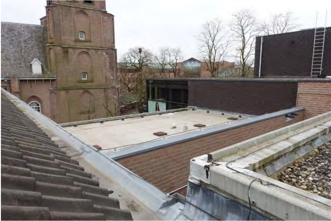
De daken van het trappenhuis (rechts) uit 1980 en de entree (links) uit 2004. Het hoge deel geheel rechts betreft de machinekamer van de lift. Links daarvan ligt het dak boven de trappen. De donkere geveldelen betreffen de nieuwbouw uit 2004. Op de achtergrond de Oude Kerk.
