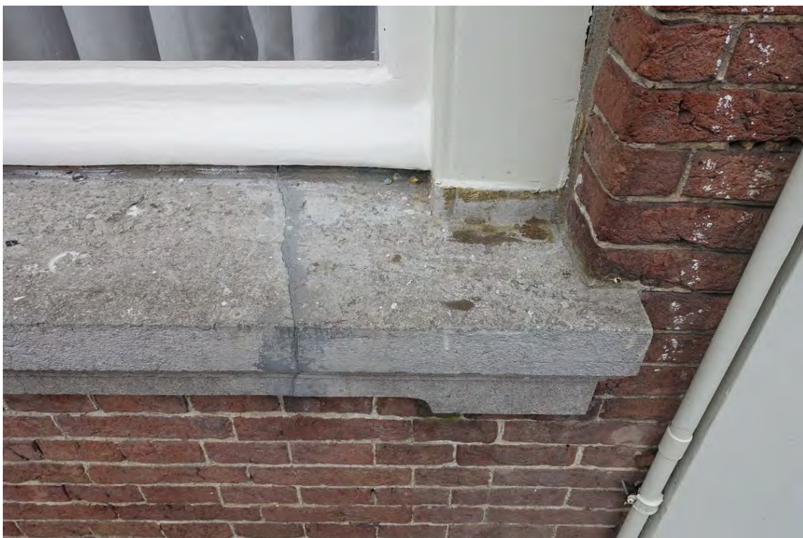
De hardstenen dorpel links van de entree. De neuten onder de kozijnen zijn onderdeel van de dorpel. In het verleden werd dit vaak zo uitgevoerd, modern werk voert dit in twee delen uit. Het kozijn heeft een duivenjager profiel. Rechts de afgevoegde naad naar het metselwerk.
