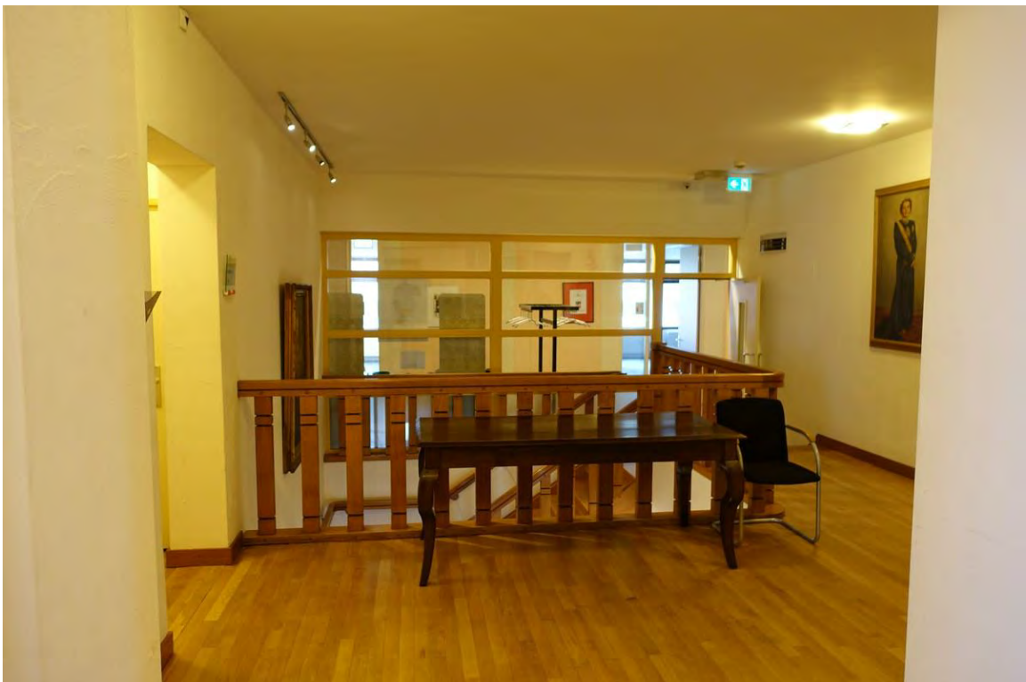
De overloop op de verdieping van het tussenlid. De verhoudingen komen hier niet heel goed uit, mede vanwege het niveauverschil tussen de twee bouwdelen. De vloer van eiken parket is in 1980 aangebracht.
