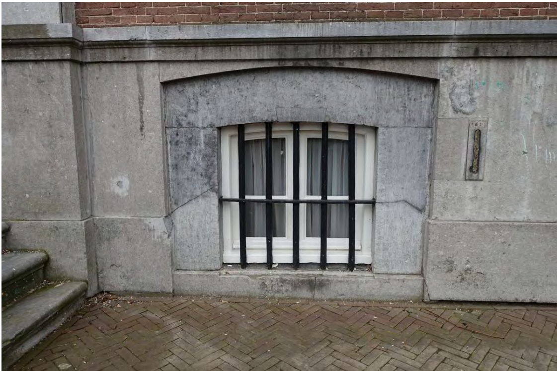
Het kelderlicht direct rechts van de trap. De hardstenen platen rond de kelderlichten lijken van jongere datum dan het werk van de plint, het is goed mogelijk dat de openingen zijn verkleind. Rechts de brievenbus die eerst is toegevoegd en later is dichtgezet.
