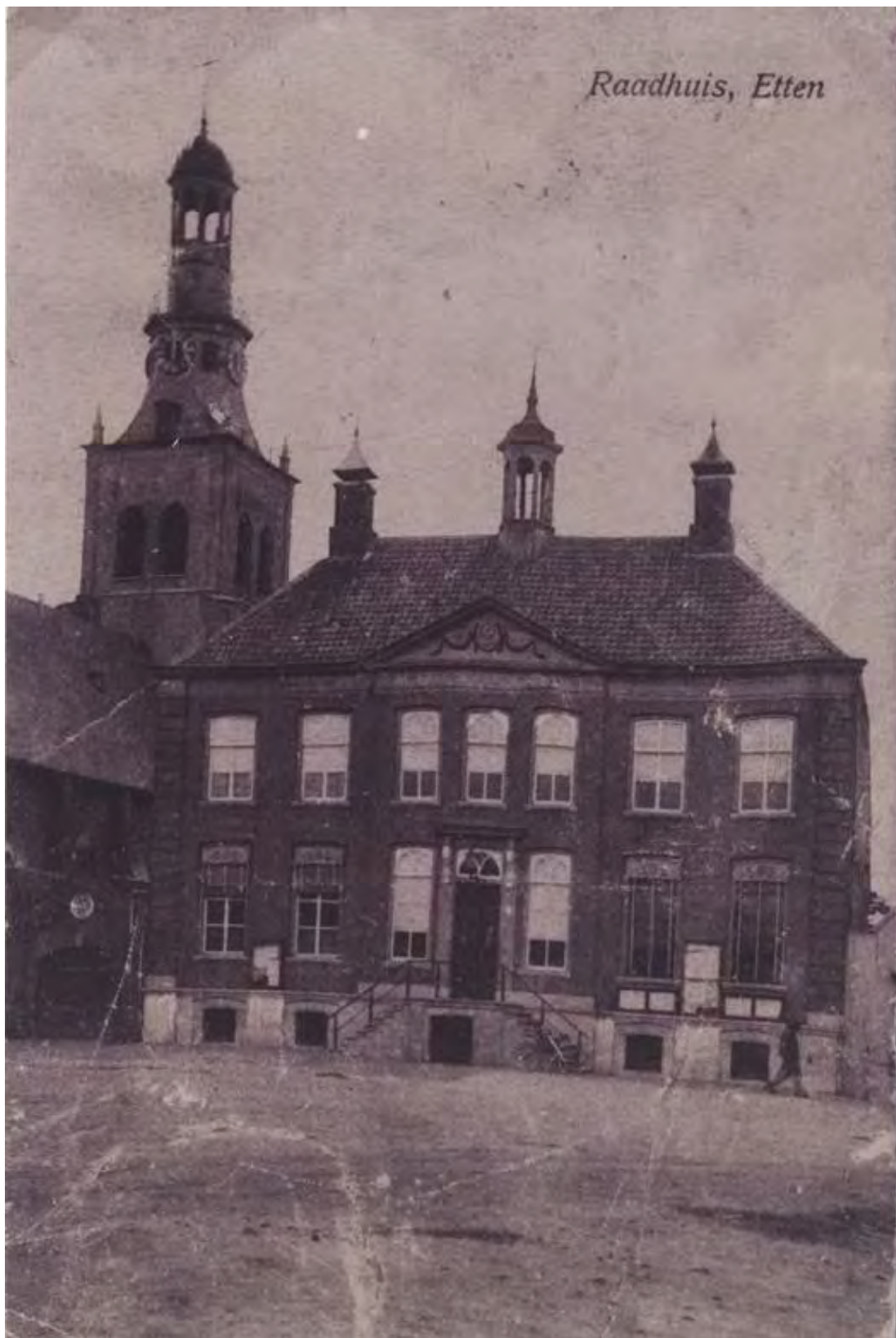
Foto uit 1900 van de voorgevel van het raadhuis (WBA RAW014018114). De oorspronkelijke roedeverdeling is niet meer aanwezig. De vensters in de risaliet zijn voorzien van zwikken, wat goed bij een datering rond 1830 past. Boven de plint zijn op meerdere plaatsen papieren (met bekendmakingen) geplakt.
