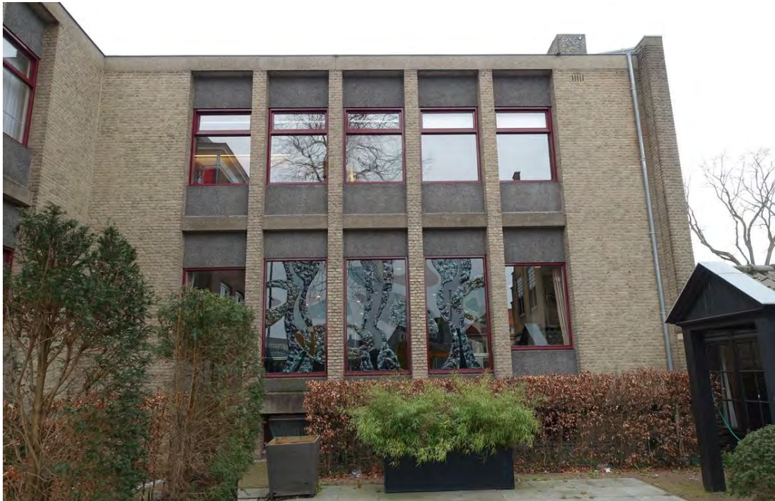
De voorgevel van bouwdeel 1963. Het metselwerk en de structuur dateren uit 1963, de vensters zijn in 1980 vernieuwd. Toen zijn ook de glasappliqués geplaatst op de plaats van de entree.
