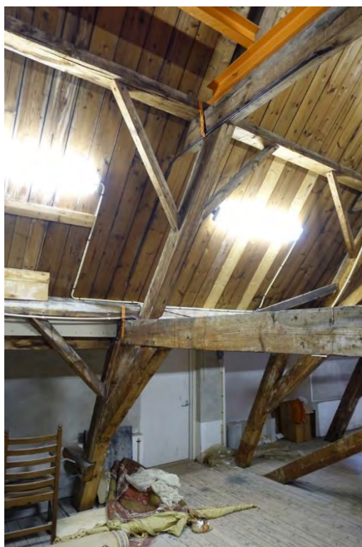
Links de stalen draagconstructie uit 1963 waarop het torentje staat. Op de voorgrond de betonnen onderslag die op de dragende muur is aangebracht. De schoren en standvink in het juk zijn oorspronkelijk (1776). Rechts de stapeling van juk en A-spant aan de zijde van de achtergevel.
