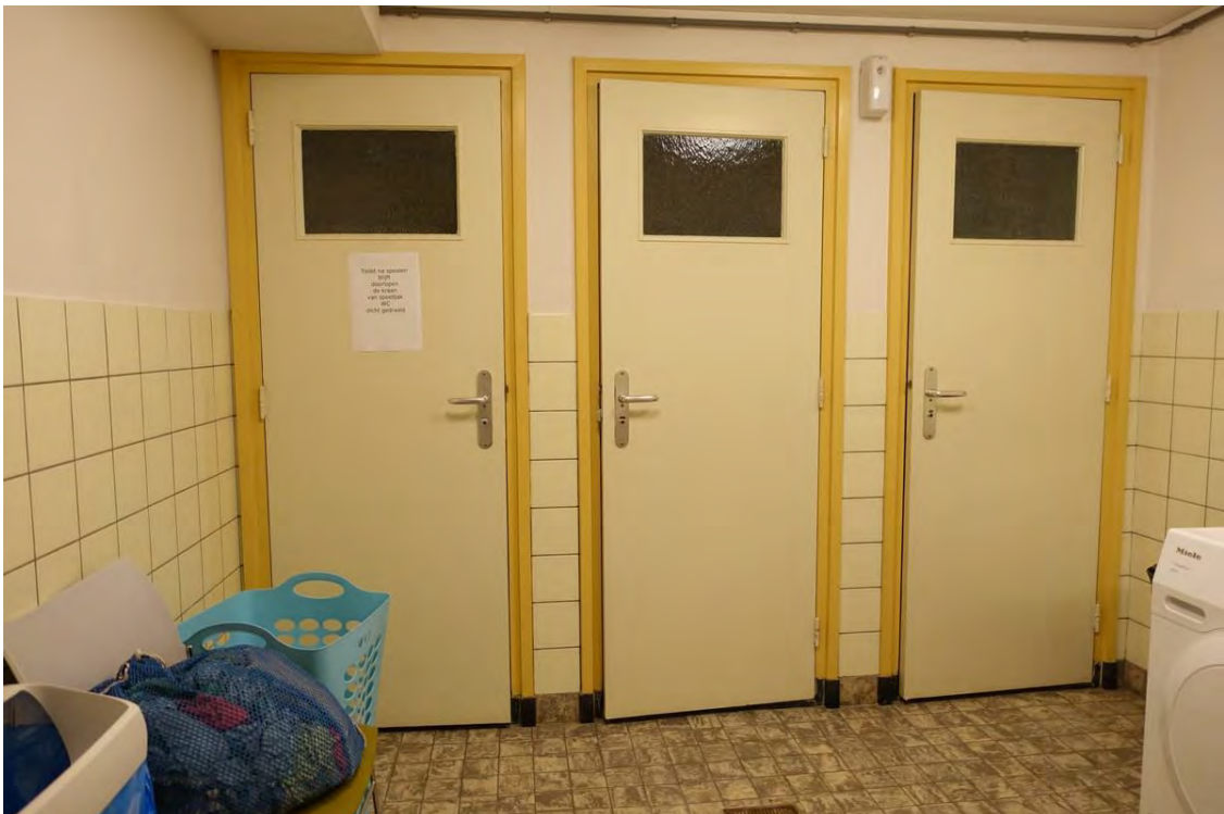
De toiletgroep in de kelder heeft de oorspronkelijke deuren, vloeren en betegeling uit 1963 behouden.
