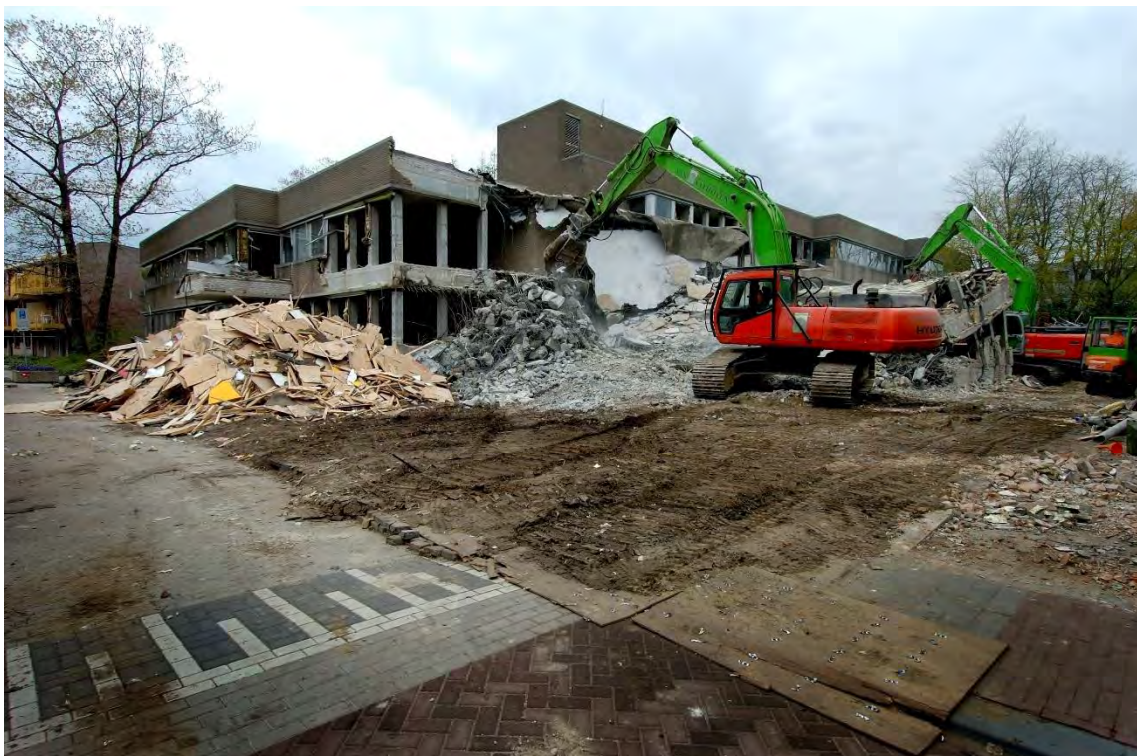
Foto uit 2004 van de sloop van de uitbreiding uit 1980 (WBA Thom van Amsterdam AM2004-00398).
