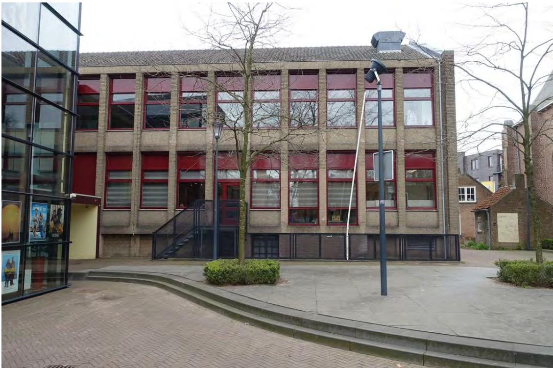
Het vrijstaande deel van de achtergevel met links de bioscoop uit 2004.
