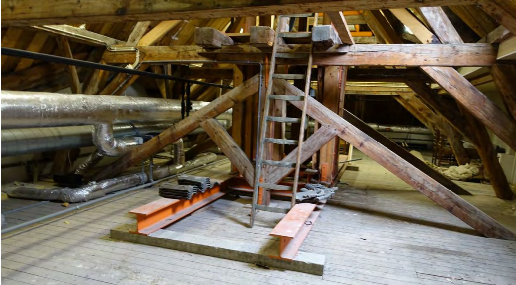
De verhoogde vloer van de zolder van bouwdeel 1776. De schoren van de constructie van het torentje vallen weg in de vloer van vuren delen.
