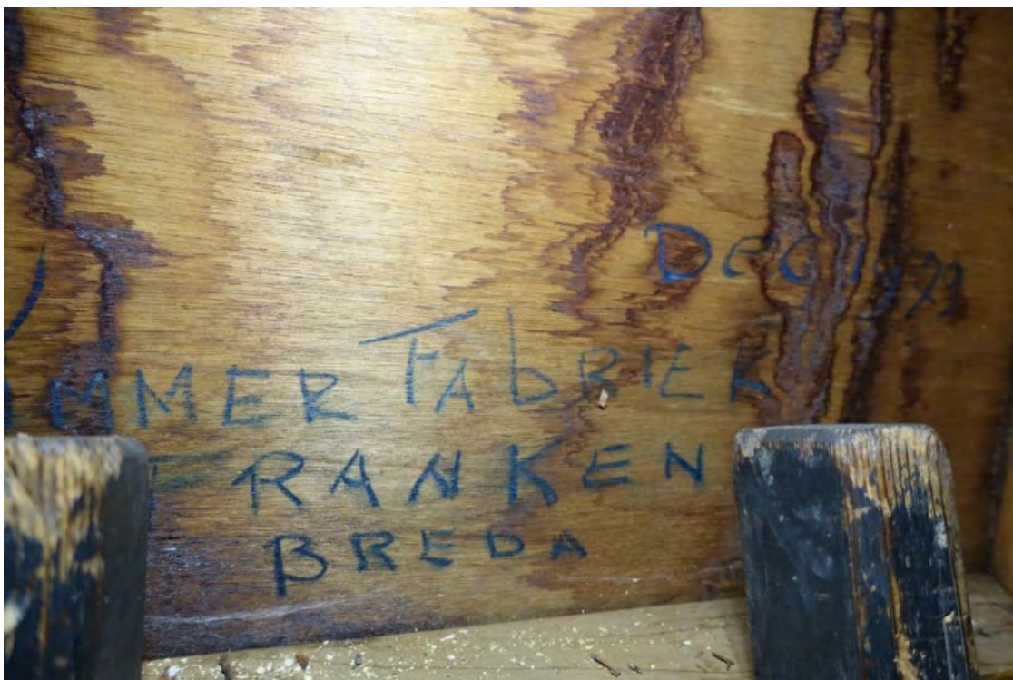
Graffiti in het torentje 'Timmerfabriek Franken Breda dec 1979'. Dit komt overeen met de foto's waarop te zien is dat de geprefabriceerde toren wordt opgehesen. Het gebruik van tropisch hardhout in de restauratie was toen nog redelijk gebruikelijk.
