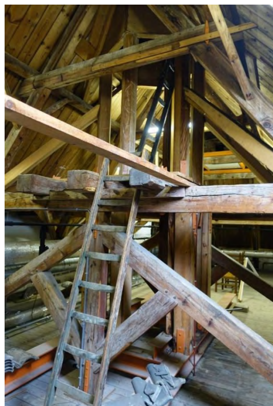
Links de aanheling van het tussenlid op de kapconstructie. Hier zijn de muurplaat en borstwering verwijderd. Rechts zicht op de drie balken die op de dekbalk liggen en waar het torentje oorspronkelijk op stond.
