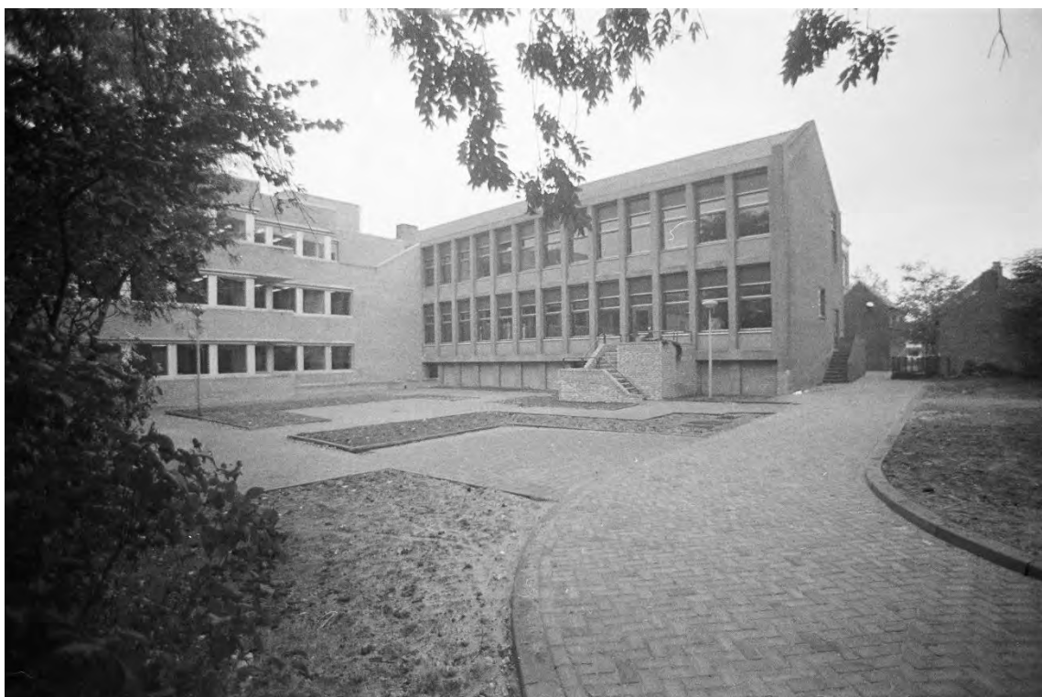
Een foto uit 1979 met de gereedgekomen ruwbouw van de uitbreiding aan de linkerzijde en de aanpassingen aan de achtergevel van het volume uit 1963 (WBA Ben Steffen, ST10880-25-1).
