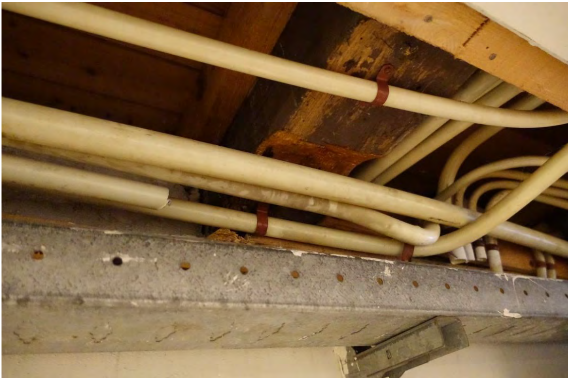
Het plafond van de kelder aan de linkerzijde van bouwdeel 1776. Hier is boven het afgetimmerde plafond een grenen balk zichtbaar. Deze dateert van voor 1963. Gezien de ruwe vuren delen hierop is de betonvloer op de balklaag gestort en is deze waar mogelijk gehandhaafd. Aan de rechterzijde en bij de hal is er geen balklaag meer aanwezig; de betonvloer is in het zicht gelaten.
