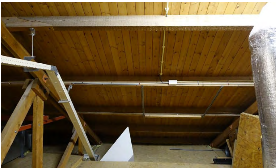
Het dakvlak aan de achterzijde met de kapvoet en het beschot op de gordingen.
