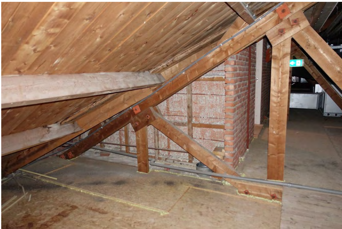
De overgang van het rechthoekige volume naar het tussenlid. De gemetselde binnenwand draagt op de kolommen die de gang vormen.
