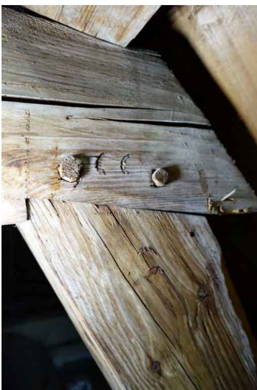
Links de kapvoet aan de zijde van de voorgevel met blokkeel en aangepaste ondersteuning van de goot. Rechts het merk CC.
