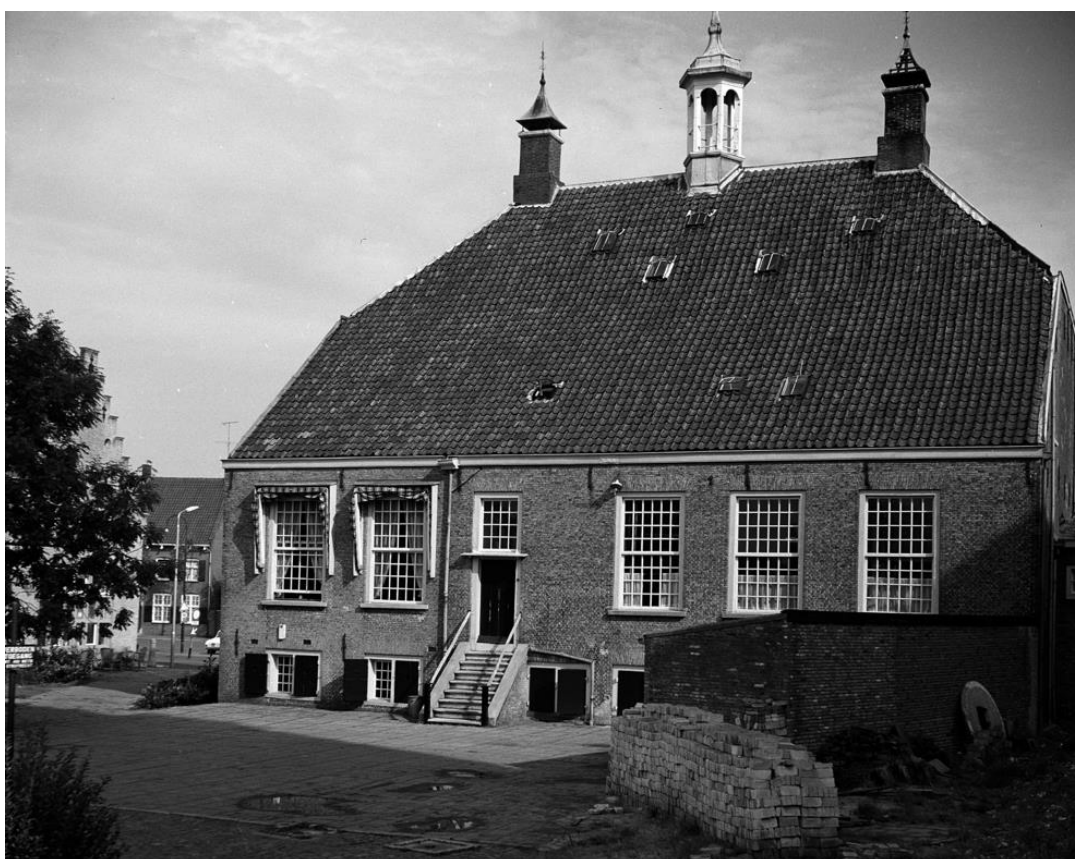
Foto van de achterzijde van het raadhuis uit 1961 (SAB C.Th. Lohmann CLO236103). Het pand aan de noordzijde (hier links) is reeds gesloopt. De achtergevel lijkt grotendeels uit 1776 te dateren.
