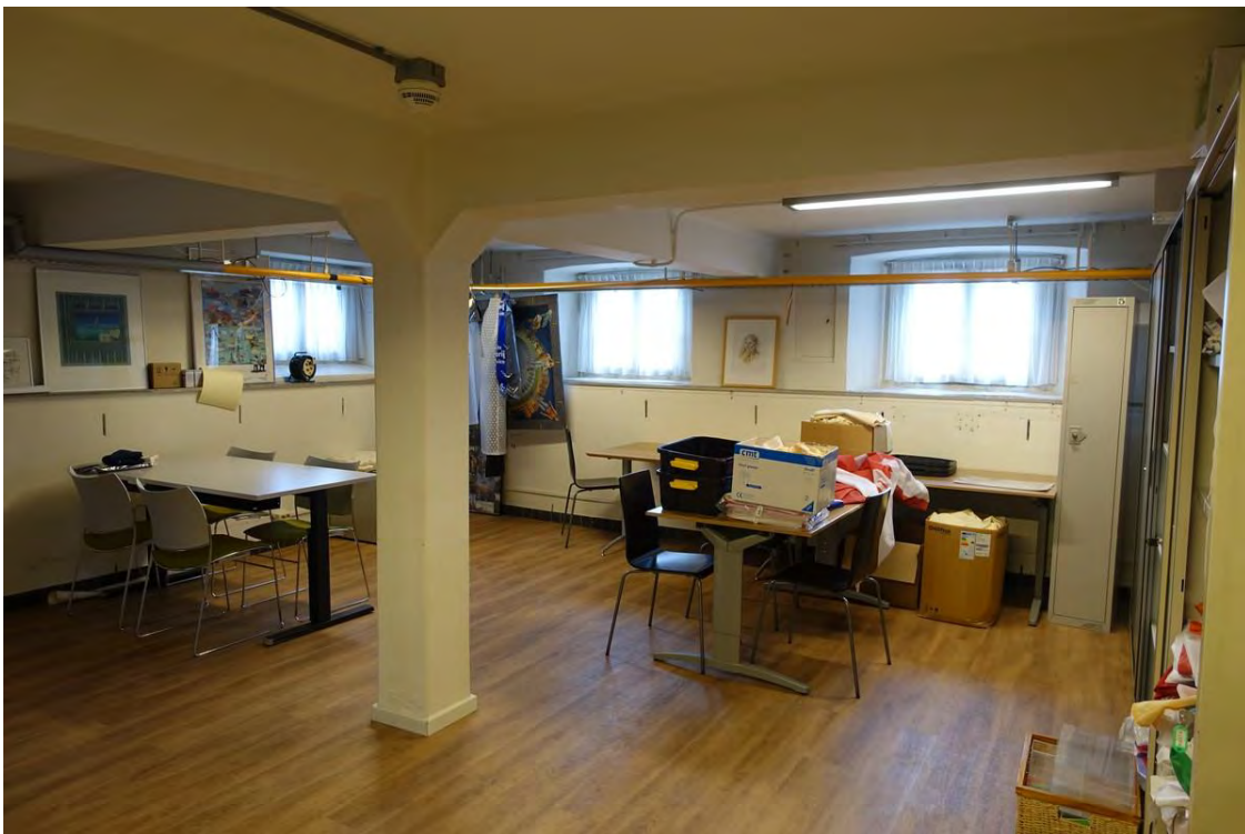
De kelder aan de rechterzijde van bouwdeel 1776. De begane grond vloer die het plafond vormt is in het zicht gelaten. Deze bestaat uit een betonvloer die met ribben is verzaamd en in het midden door een kolom wordt ondersteund.
