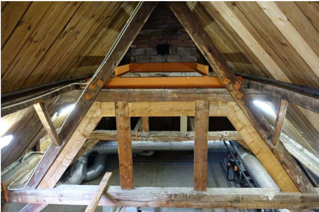
De nieuw ingebrachte ondersteuning van de schoorstenen die nodig was omdat de rookkanalen werden gesloopt. De stalen balken liggen op de trekbalk die met standvinken afdraagt naar de dekbalk.
