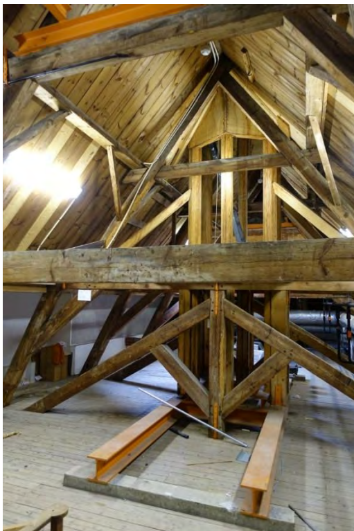
Links de stalen draagconstructie uit 1963 waarop het torentje staat. Op de voorgrond de betonnen onderslag die op de dragende muur is aangebracht. De schoren en standvink in het juk zijn oorspronkelijk (1776). Rechts de stapeling van juk en A-spant aan de zijde van de achtergevel.
