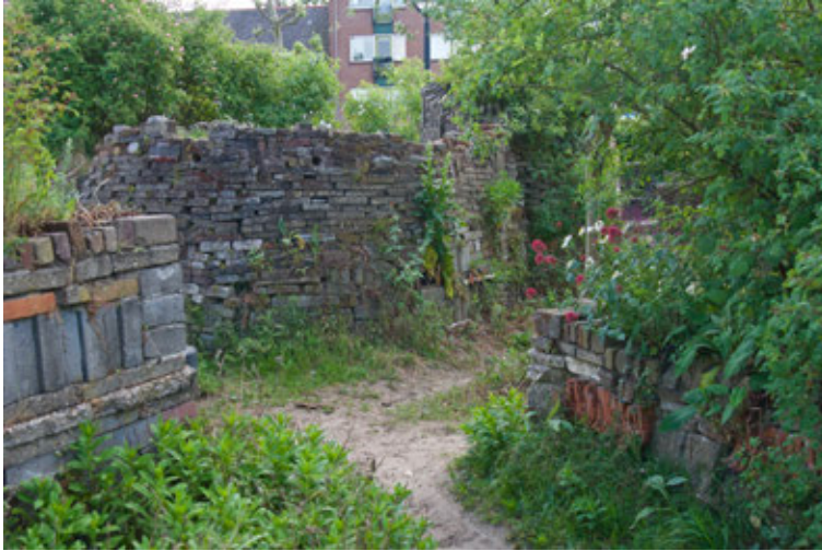
Figuur IV- 18 Stapelmuur.
