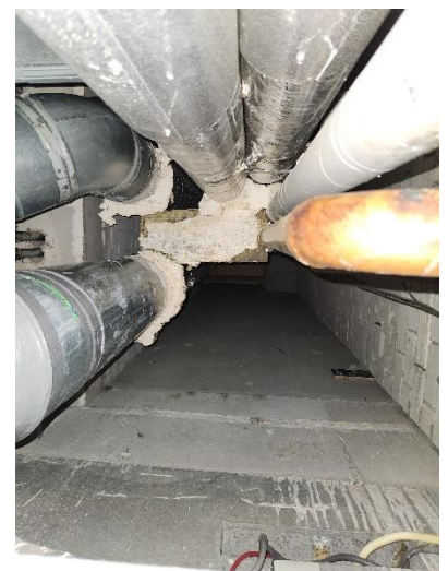
Figuur 9 bestaande stoom schacht
