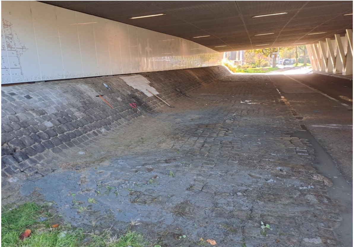
Figuur 10 - Onderzijde viaduct Bijdorp
