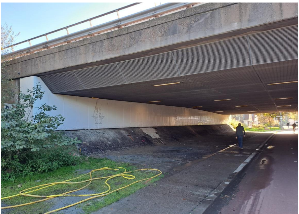
Figuur 11 - Onderzijde viaduct Bijdorp
