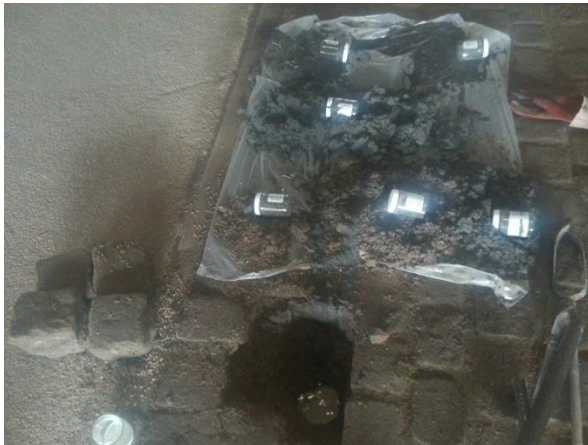
Fotonummer: 1 Omschrijving: Boring 2.5-006a
