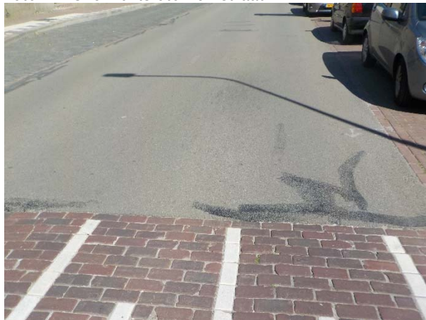
Foto 14. Overgang drempel naar asfalt Kerkstraat
