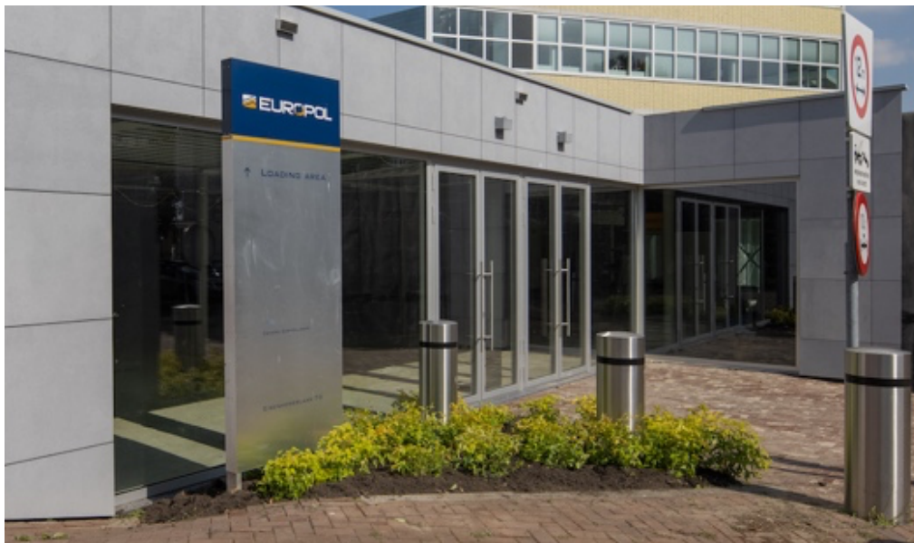
Bestaande hoofdentree van het plintgebouw TvO
