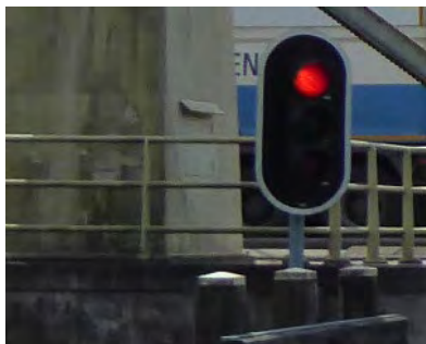
Foto 8.1: ENKEL ROOD (brug actief: niet invaren)
