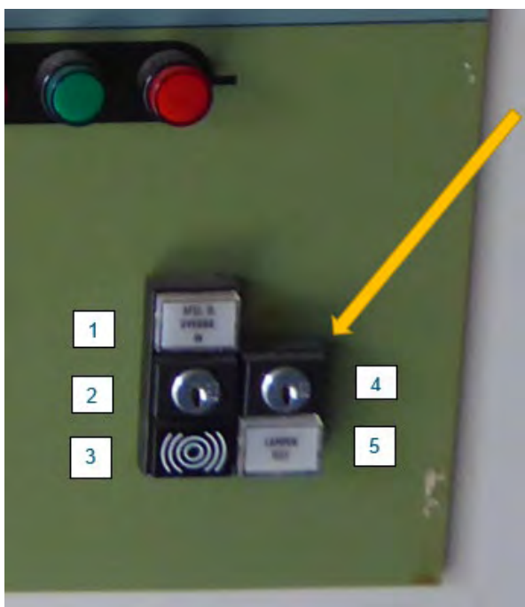
Foto 13.2: sleutelschakelaar bedienpaneel schakelruimte
