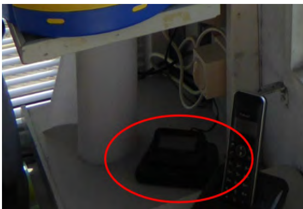
Foto 3.1: In de bedienpost de pieper van de brandweer
