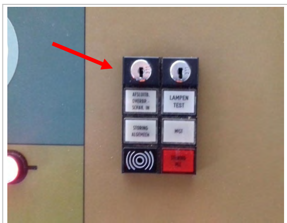
Foto 13.1: Sleutelschakelaar bedieningslessenaar bedienpost
