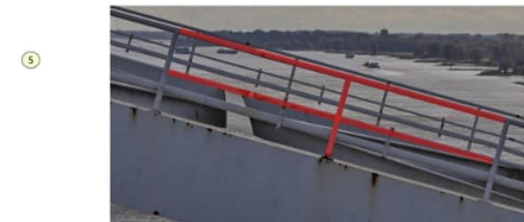
Figuur 4-13: Te verwijderen locatie 5, ca. 8 m aan buizen
