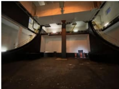
Figuur 3-35: Overzichtsfoto 1 vluchtroutes, geen noodverlichting, deels vluchtwegverlichting, deels bordjes
