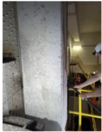
Figuur 3-1: holklinkende delen op kolom
