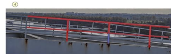
Figuur 4-7: Te verwijderen locatie 4, ca. 15 m aan buizen
