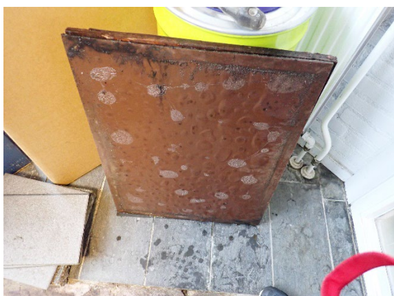
Figuur 4.3: Houten kruipluik verzadigd van vocht
