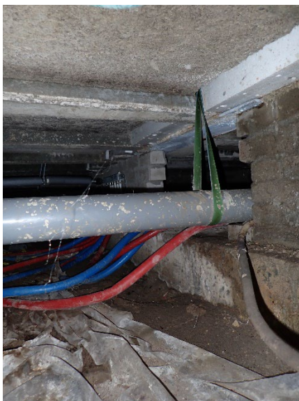
Figuur 4.9: Mangaten / doorvoeren in fundering
