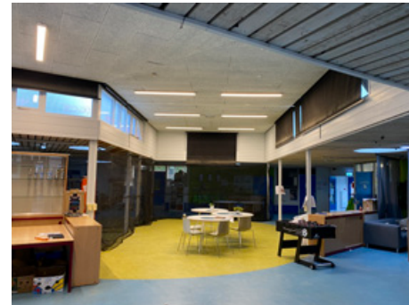
Marmoleum vloerbedekkingen, stalen kolommen, houten latten plafond
