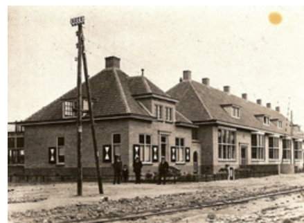
1927: Openbare school en Vereenigingsgbouw
