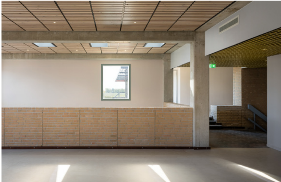
Hergebruik van metselwerk en houten latten (bron: PtSA, 'kantoor vol afval')
