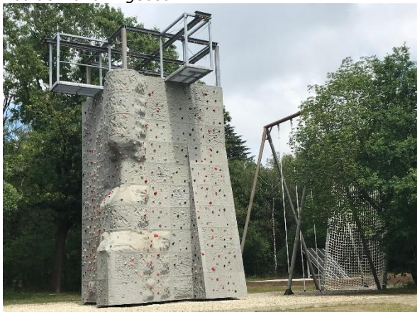
Klimtoren incl. slinger en enterinstallatie
