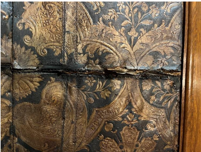
Detail Zuid-oost muur
