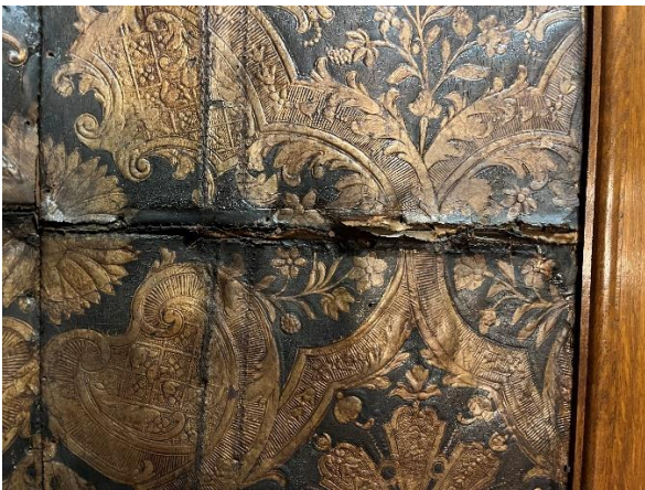
Detail Zuid-oost muur
