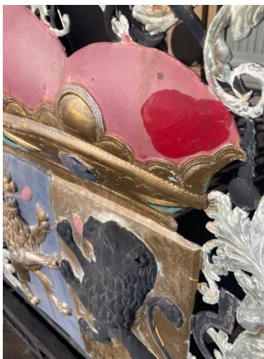
De verflagen zijn in het geheel wat dof van uitstraling: bij verzadiging komt tijdelijk de eigenlijke kleur naar voren
