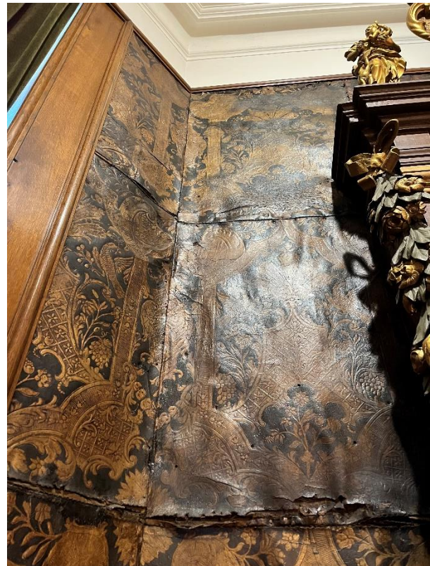
Detail zuid-oost muur
