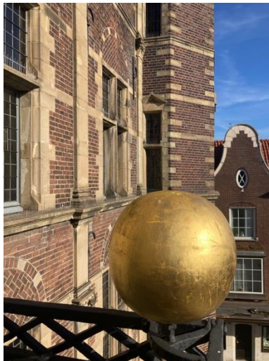
Beschildering met goudverf versus vergulding met bladgoud: het verschil in uitstraling met de gouden bollen is groot
