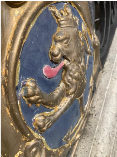
Beschildering met goudverf versus vergulding met bladgoud: het verschil in uitstraling met de gouden bollen is groot
