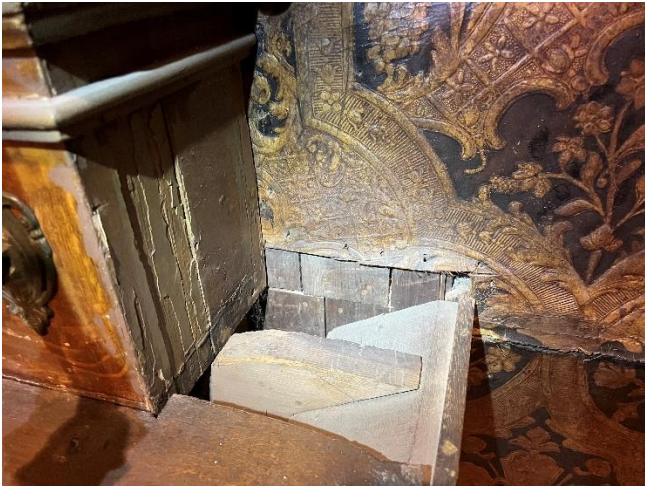
Detail west muur, rechts van de schouw
