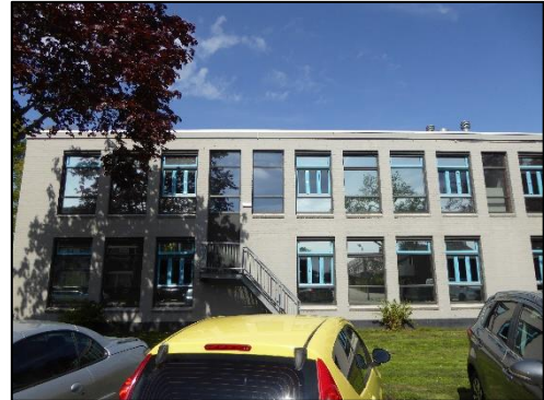
De achterzijde van het schoolgebouw;
