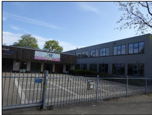
De zuidzijde van het schoolgebouw;
