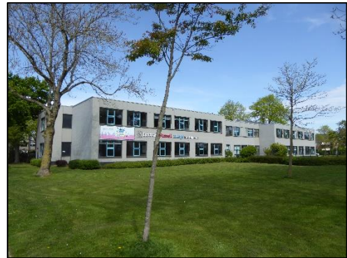
De oostzijde van het schoolgebouw;
