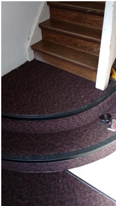
De opzet en materialisatie van de trap is grotendeels oorspronkelijk. Het tapijt op het kwartronde plateau aan de onderzijde is een latere toevoeging.
