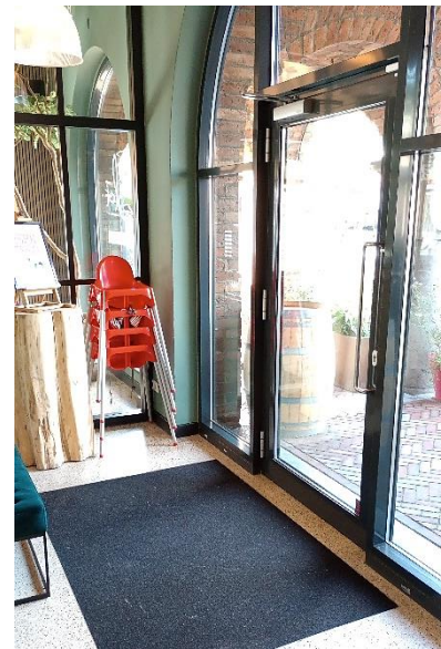
Bij de hoofdentree is tussen de draagconstructie van het gebouw een tochtportaal ingebouwd (links). De entreepui is in 2001 vervangen (rechts). Hierbij is de oorspronkelijke kozijnindeling aangehouden.
