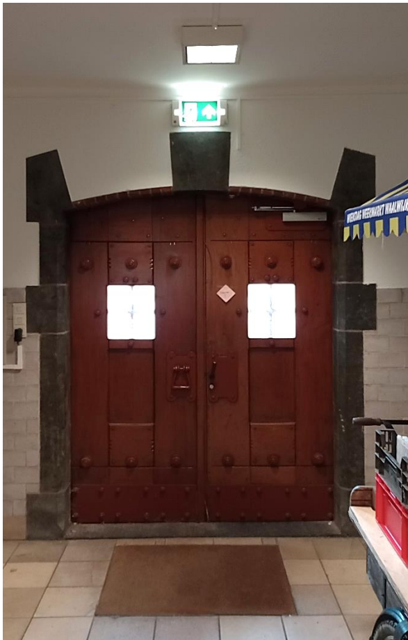
Zware, dubbele houten deur met rondom elementen van hardsteen (links). De hardsteen elementen zijn gefrijnd in kathedraalslag (rechtsonder). Links naast de deur bevindt zich een brievenbuskast (rechtsboven).
