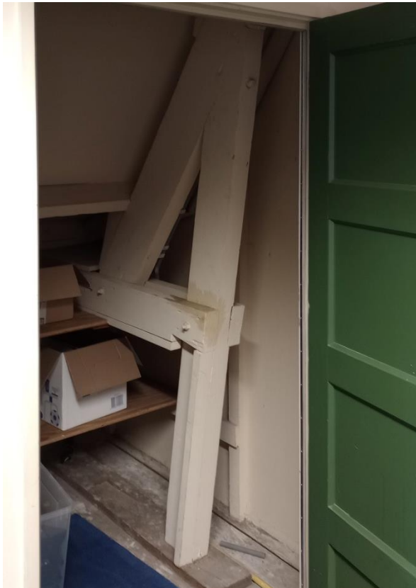
Kapsant met kreupele stijl en blokkeel zoals zichtbaar in een inbouwkast aan de noordzijde van het gebouw (links) en achter een lichte binnenwand (rechts) aan de zuidzijde.
