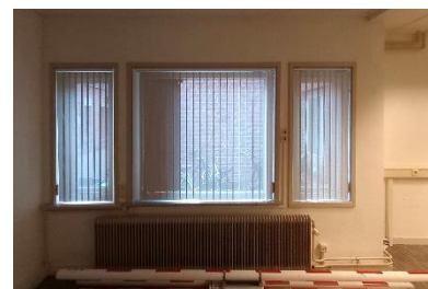
Overzicht van ruimte 0.12, gezien richting de voorgevel (links). Bij de drie vensters in de noordgevel verraden het afwijkende kozijn en de stenen vensterbank dat het middelste venster later is ingepast (rechts).
