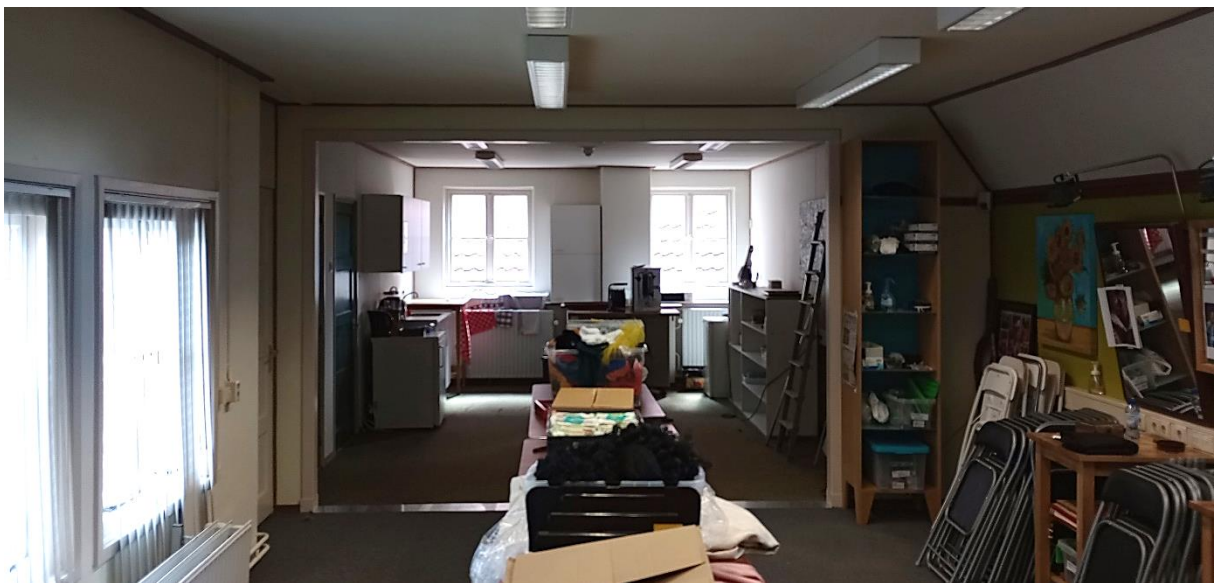
Zicht in ruimten 2.04 en 2.05, richting de noordzijde (boven) en richting de zuidgevel (onder). De beide ruimten zijn door een groot portaal in de tussenwand met elkaar verbonden.
