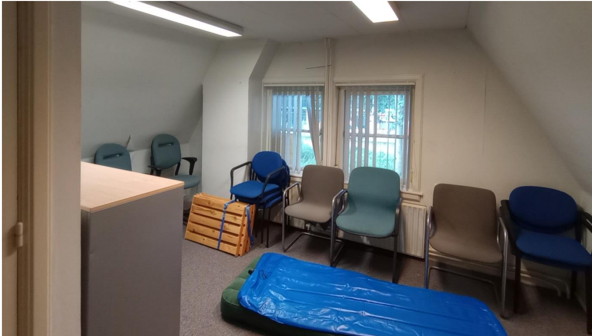
Overzicht van de (slaap)kamer aan de achterzijde (noordzijde). In de noordwest hoek is een rookkanaal aanwezig. In de achtergevel bevinden zich twee oorspronkelijke vensters met draairamen. Het hang- en sluitwerk is in de loop der tijd vervangen.
