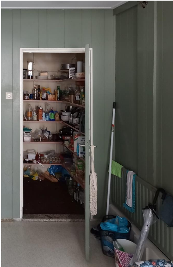
Inbouwkast in de westwand met houten betimmering (links). De inbouwkast heeft granito neuten en een granito dorpel (rechtsonder). Onder de vloerafwerking van vinyl gaat een granitovloer schuil (rechtsboven).
