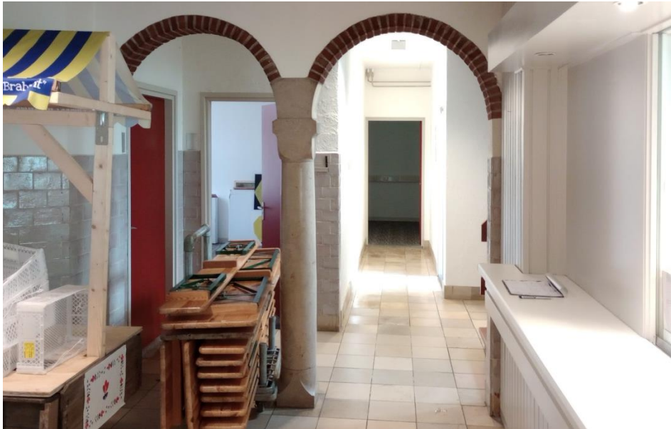
Twee getoogde doorgangen met gepolijste betonnen zuil bieden toegang tot de gang met trap (ruimte 0.09).
