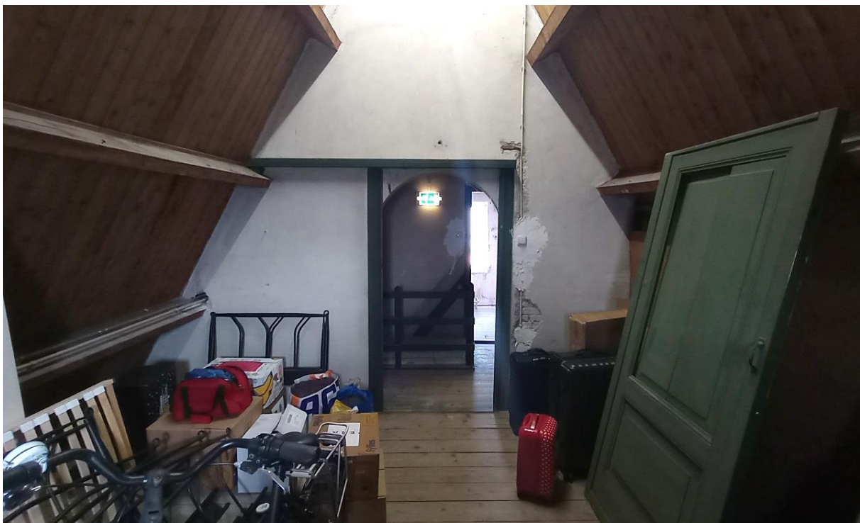
Zicht vanaf de zolder richting de overloop. De oorspronkelijke schuifdeur staat los in de ruimte.
