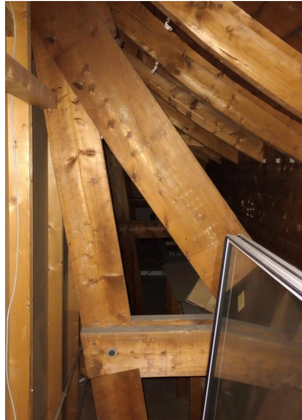
Kapsant met kreupele stijl en blokkeel zoals zichtbaar in een inbouwkast aan de noordzijde van het gebouw (links) en achter een lichte binnenwand (rechts) aan de zuidzijde.
