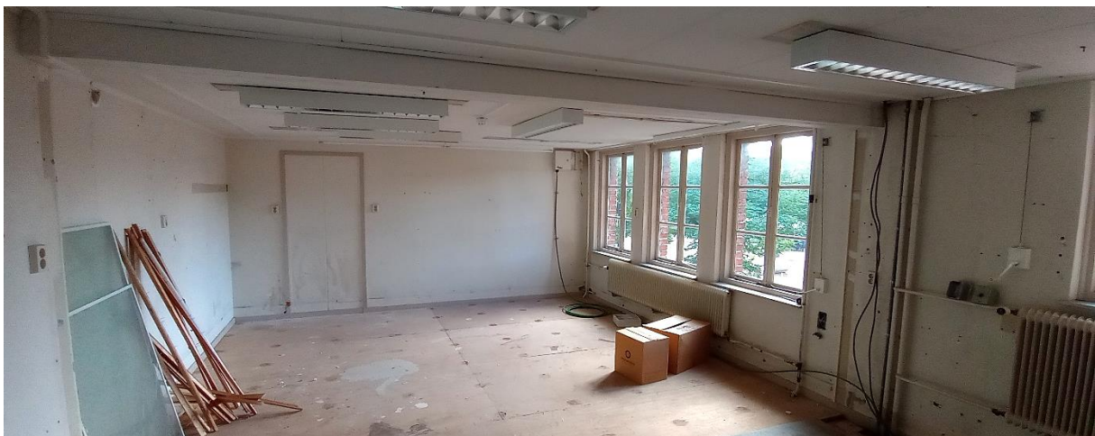
Zicht in ruimte 1.04. De omklede balk in het plafond bevindt zich op de oorspronkelijke scheiding tussen de woningen.
