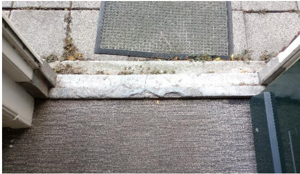
Hardstenen dorpel en neuten bij de voordeur (links) en profilering voordeur ter plaatse van de ruitjes (rechts).
