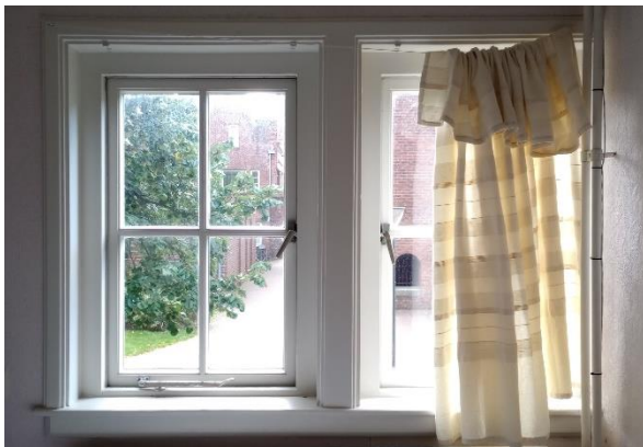
De vensters met draairamen in de voorgevel (zuidzijde) zijn oorspronkelijk. Het hang- en sluitwerk is in de loop der tijd vervangen.
