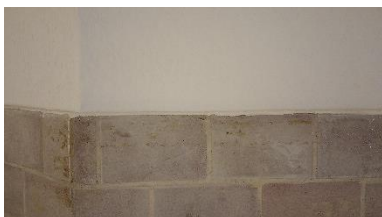
De wanden zijn voorzien van een lambrisering van lichtgrijze geglaazuurde tegels (links) met erboven grof structuurpleister (midden). Tussen wanden en plafond is een holle hoek gemaakt (rechts).
