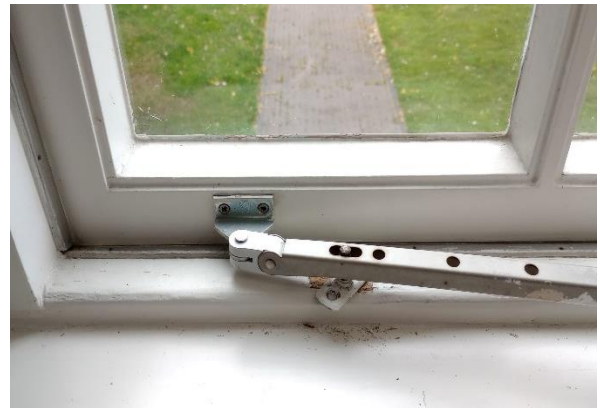
De vensters met draairamen in de voorgevel (zuidzijde) zijn oorspronkelijk. Het hang- en sluitwerk is in de loop der tijd vervangen.
