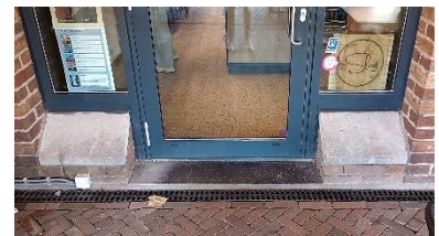
Scheur in de granitovloer (links) en doorbraak borstwering / raamdorpel ten behoeve van tweede entree (midden en rechts).
