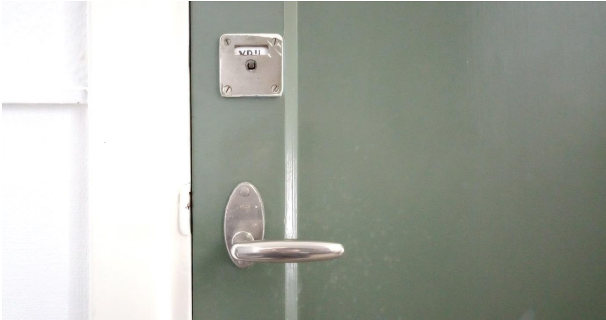
De deuren naar het toilet en de badkamer hebben nog hun oorspronkelijke hang- en sluitwerk en vrij / bezet aanduiding.
