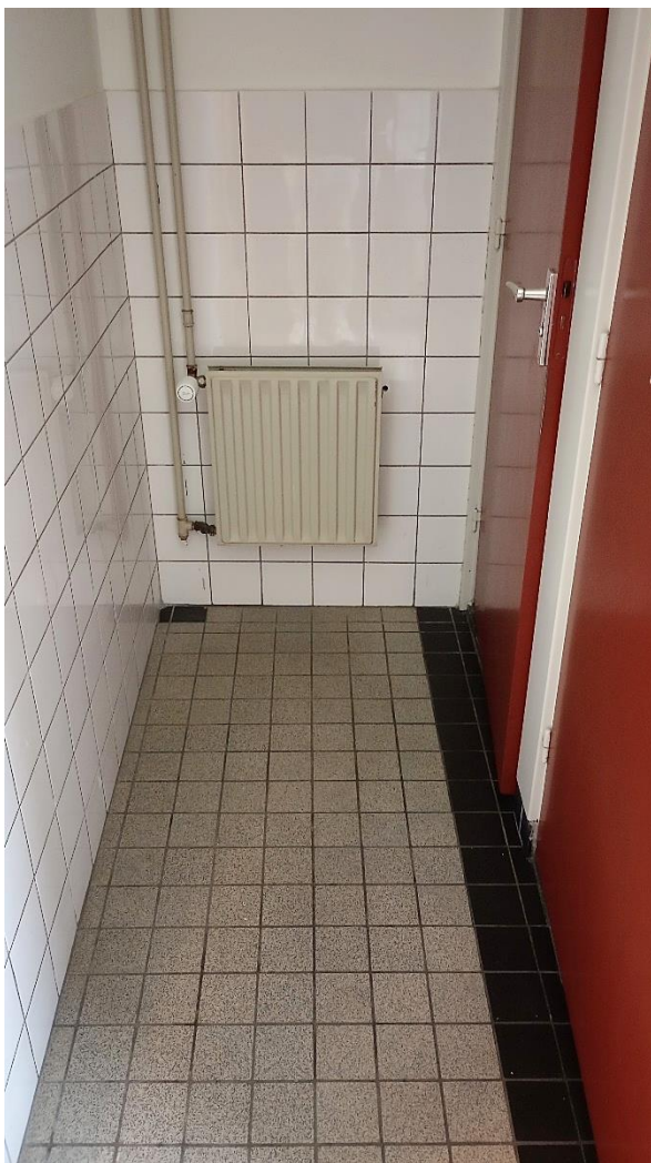
In de voorruimte verradt de onderbroken bies van zwarte vloertegeltjes ruimtelijke aanpassingen in het verleden (links). Boven de wastafel bevindt zich een groot venster (rechts).
