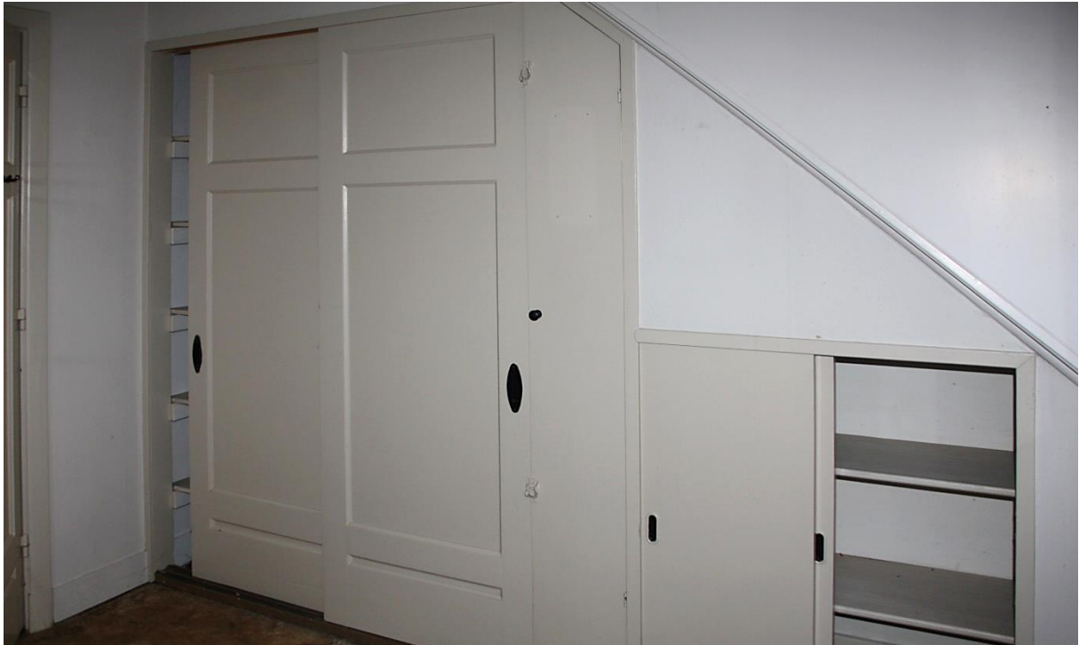
Inbouwkast tegen de westwand in 2021.
