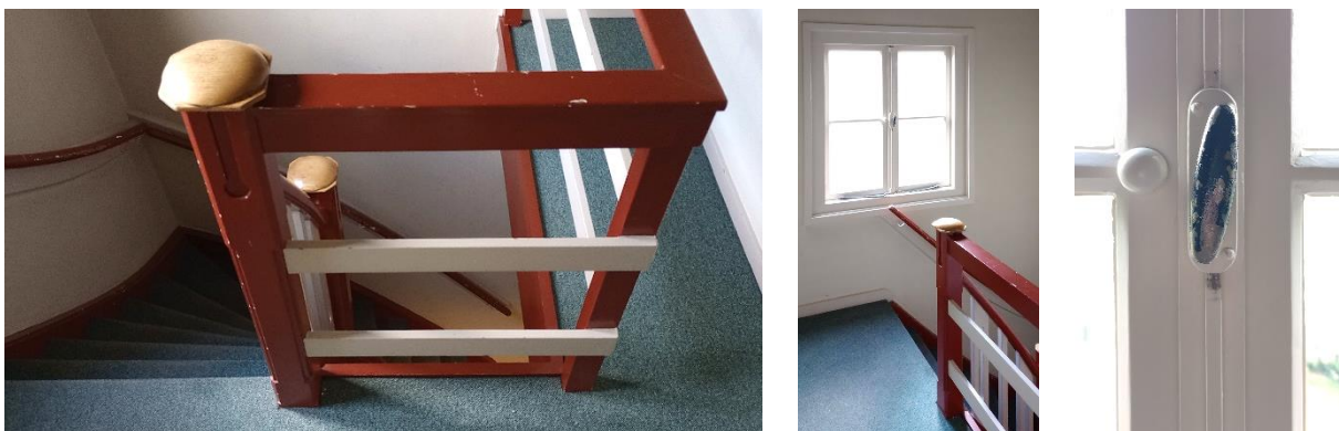
Trap met later toegevoegd hekwerk (links), venster in de achtergevel (midden) met espagnoletsluiting (rechts).
