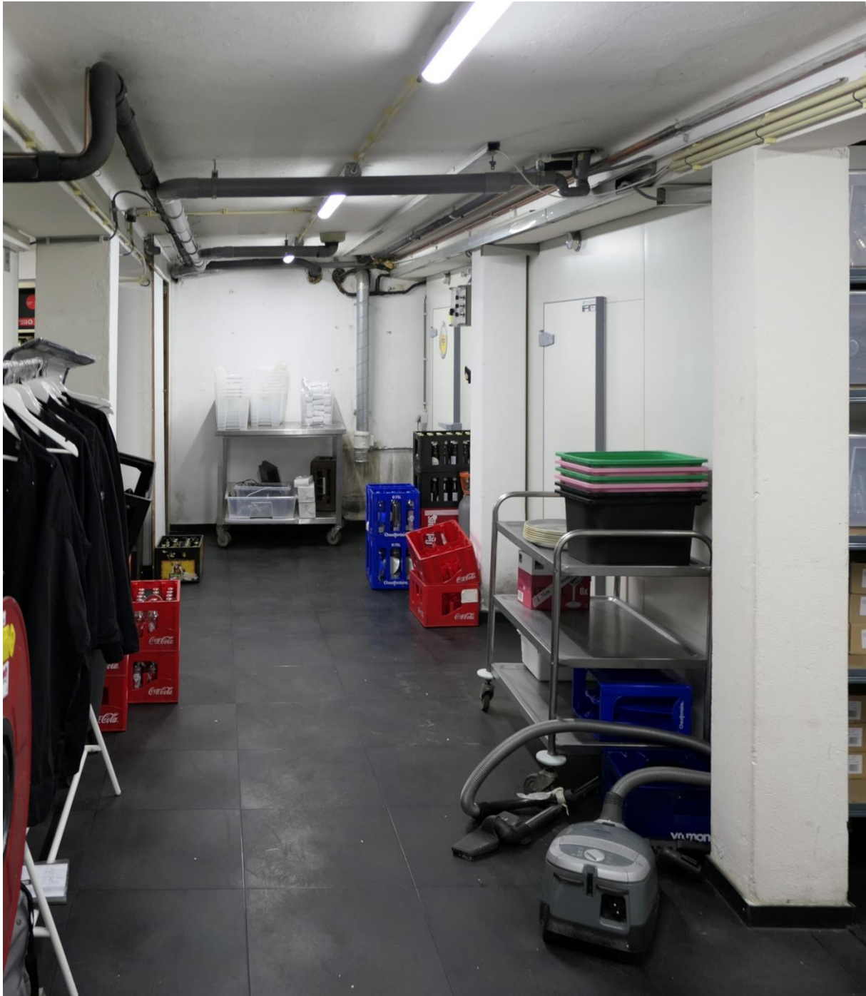
In het magazijn is de betonnen draagconstructie van het gebouw (kolommen en vloerbalken) prominent aanwezig.
