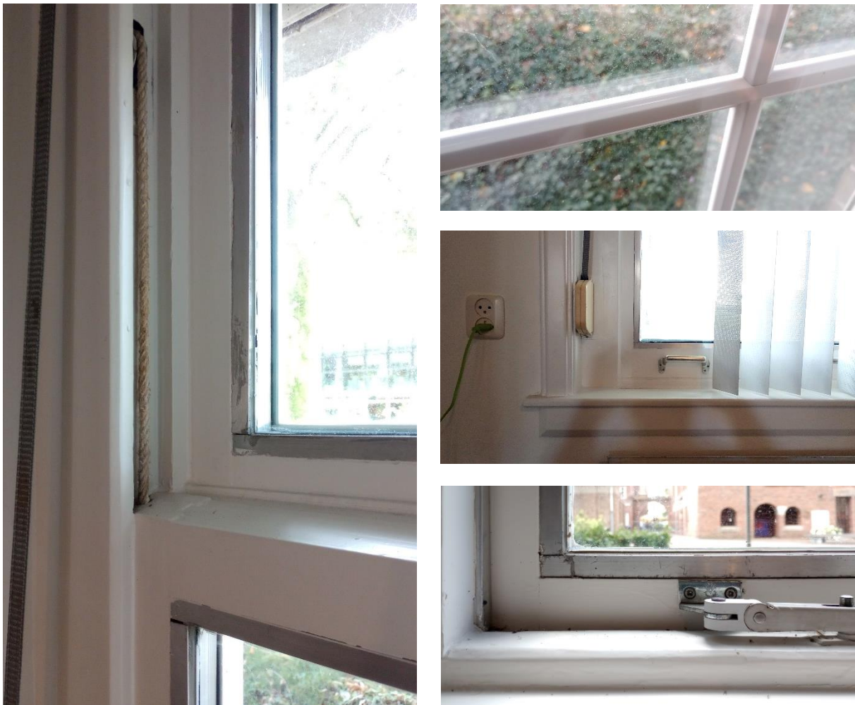
Details van de vensters aan de voor- (rechtsonder) en achterzijde (links, rechtsmidden). Het oorspronkelijke enkelglas is in de loop der tijd met behulp van blank aluminium glaslatten vervangen door dubbelglas. Tussen het dubbelglas zijn kunststof roeden opgenomen (rechtsboven).
