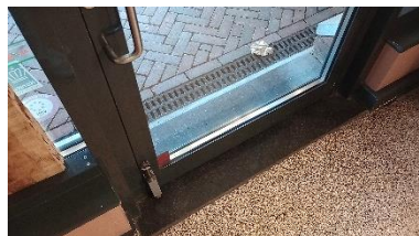
Scheur in de granitovloer (links) en doorbraak borstwering / raamdorpel ten behoeve van tweede entree (midden en rechts).
