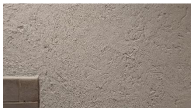
De wanden zijn voorzien van een lambrisering van lichtgrijze geglaazuurde tegels (links) met erboven grof structuurpleister (midden). Tussen wanden en plafond is een holle hoek gemaakt (rechts).
