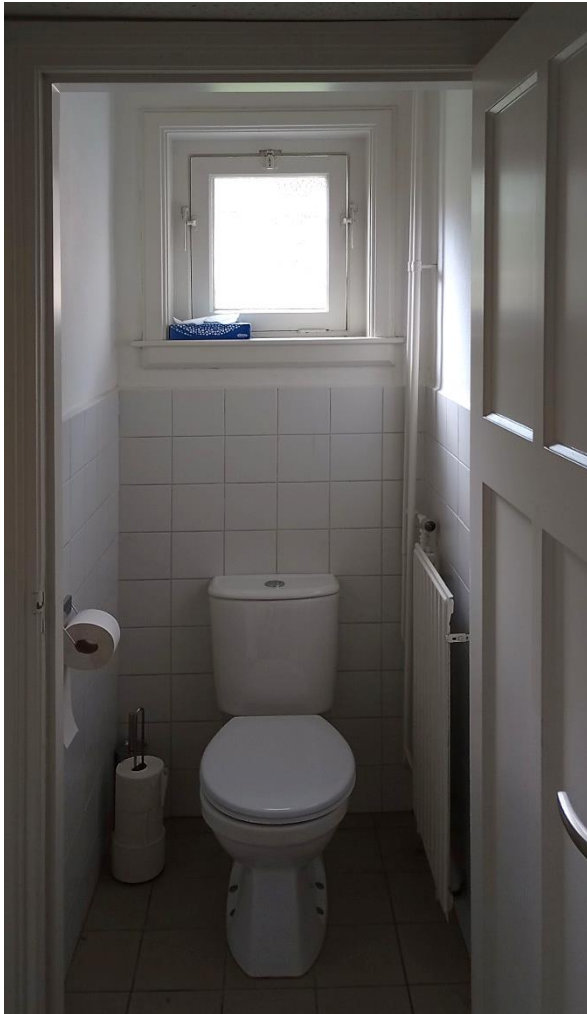
Op de deur en het venster na is het toilet geheel vernieuwd (links en rechtsonder). Het oorspronkelijke venster heeft een kiepraam met figuurglas en hang- en sluitwerk uit de bouwtijd (rechtsboven).
