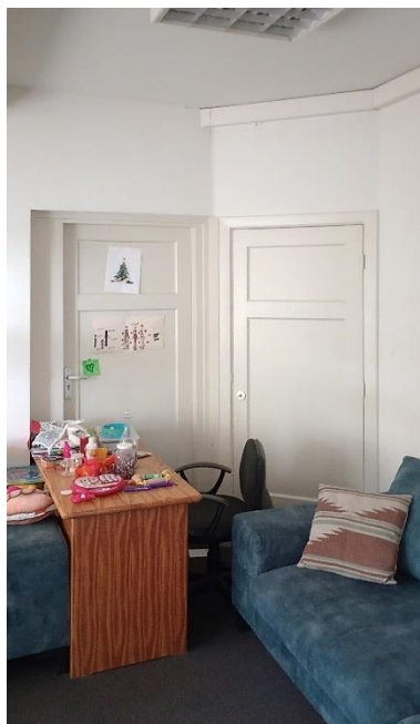
Niet oorspronkelijke deur tussen de kleine en de grote woonkamer (links), hoekkast en in 1973 gerealiseerde doorgang in de woningscheidende wand tussen Raadhuisplein 6 en 7 (midden) en venster in de voorgevel (rechts).
