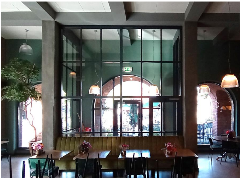
Bij de hoofdentree is tussen de draagconstructie van het gebouw een tochtportaal ingebouwd (links). De entreepui is in 2001 vervangen (rechts). Hierbij is de oorspronkelijke kozijnindeling aangehouden.
