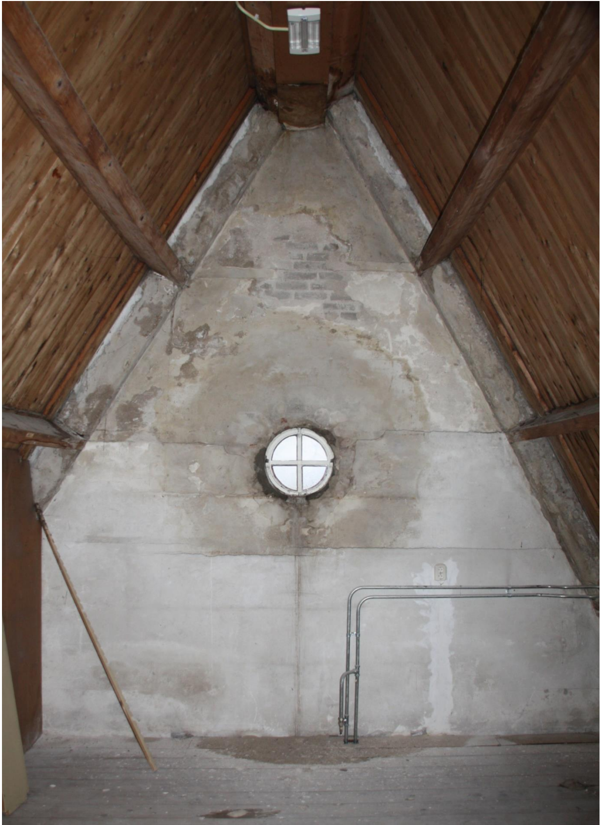
Gordingkap, houten dakbeschot en houten plankenvloer op de zolder van Raadhuisplein 7. Zicht richting de voorgevel (westzijde).
