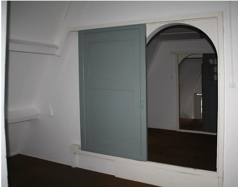
Twee getoogde doorgangen met schuifdeuren geven toegang tot de voorzolder en de zolder (links). Op de zolder staat midden in de ruimte een rookkanaal (rechts).
