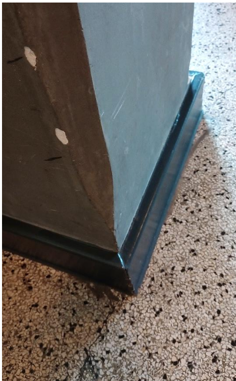
Geprofileerde kolom (links), geperforeerd systeemplafond tussen de vloerbalken (rechtsboven) en lichte overgang in hoogte in de granitovloer tussen de panden Grotestraat 263 en Raadhuisplein 7 (rechtsonder).
