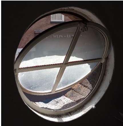
Vensters met stalen kozijnen en ramen in de entresol.
