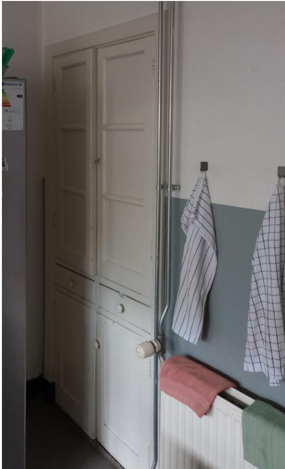
Inbouwkast met deurtjes en lades (links) en afvoerkoof van de oorspronkelijke stookplaats / fornuis (rechts).
